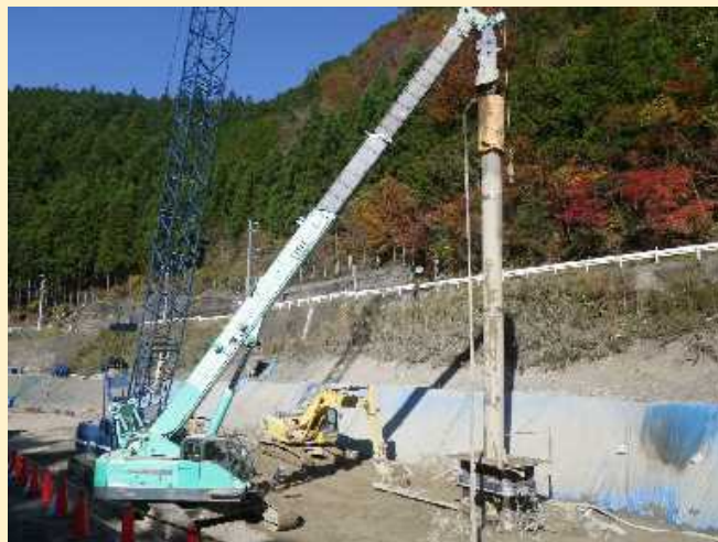
▲ダウンザホールハンマによる 先行掘削(但東開発(株)施工)
