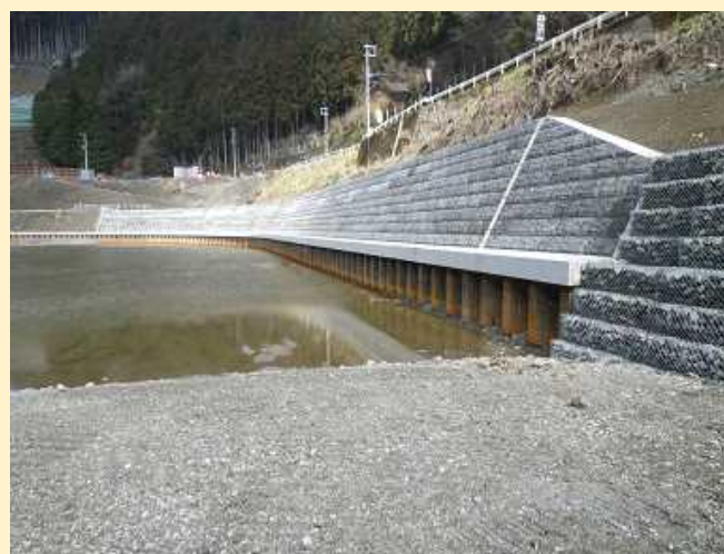
▲護岸工完成後(上流から下流を望む)
