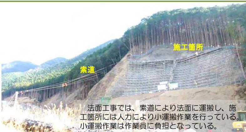
法面工事では、索道により法面に運搬し、施工箇所には人力により小運搬作業を行っている。小運搬作業は作業員に負担となっている。
