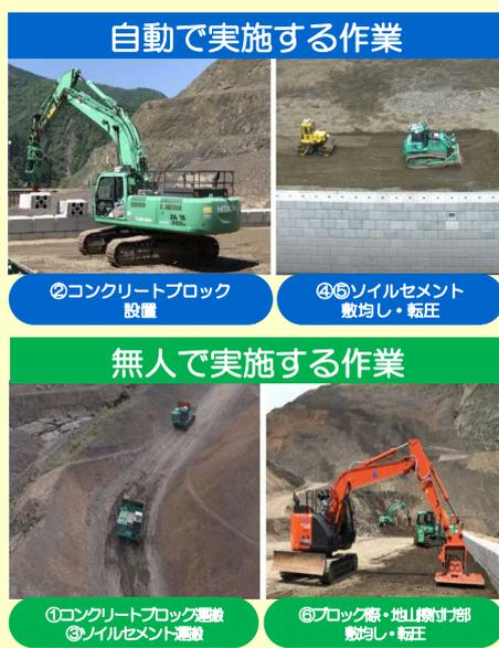
赤谷地区の砂防堰堤工事で行われた自動化・無人化施工
