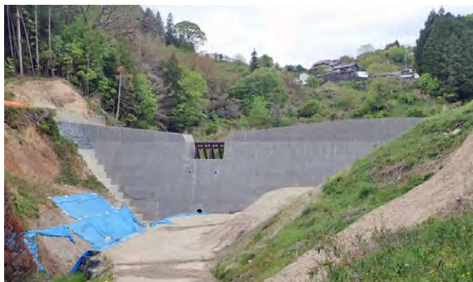
室生口堰堤（本堤） 【令和2年3月完成】
