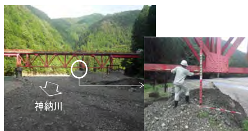
土砂流出による河床上昇 (神納川 藤原橋付近 (十津川村))
