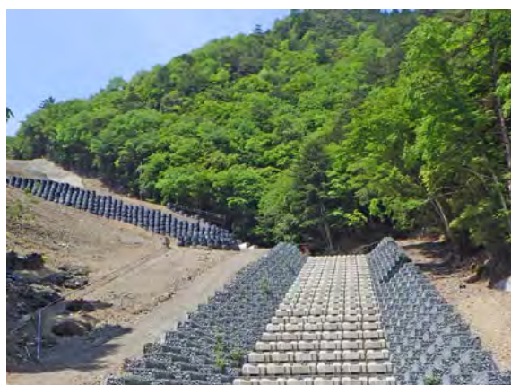
長殿地区 仮排水路工【平成 28 年 3 月完成】
