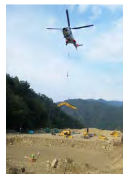
ヘリコプターによる分解型重機の運搬
