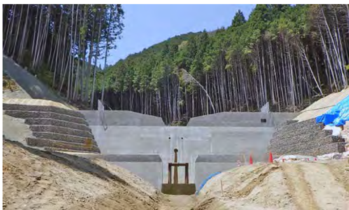
谷出第3堰堤（本堤） 【令和2年3月完成】
