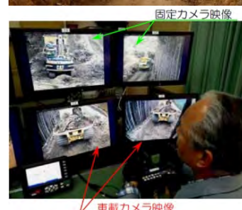
無人化施工による頭部排土 (北股地区)
