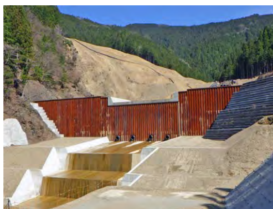
北股地区 2号砂防堰堤【平成 29 年 1 月完成】
