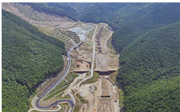
砂防施設及び道路の整備が進んだ熊野地区
