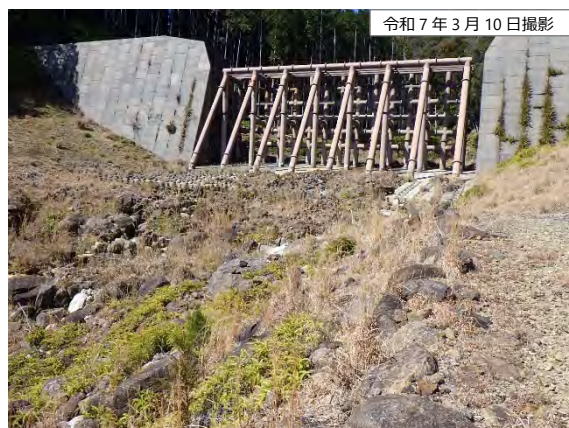
しりけんだにがわ (尻剣谷川2号砂防堰堤)
