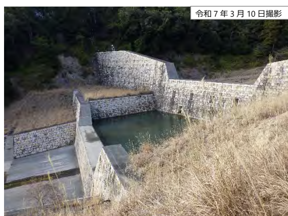
ひらのがわ (平野川1号砂防堰堤)
