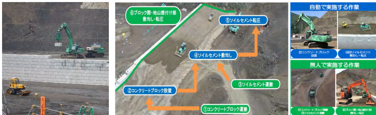
赤谷地区における自動化施工
