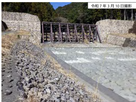
いんようがわ (陰陽川砂防堰堤)
