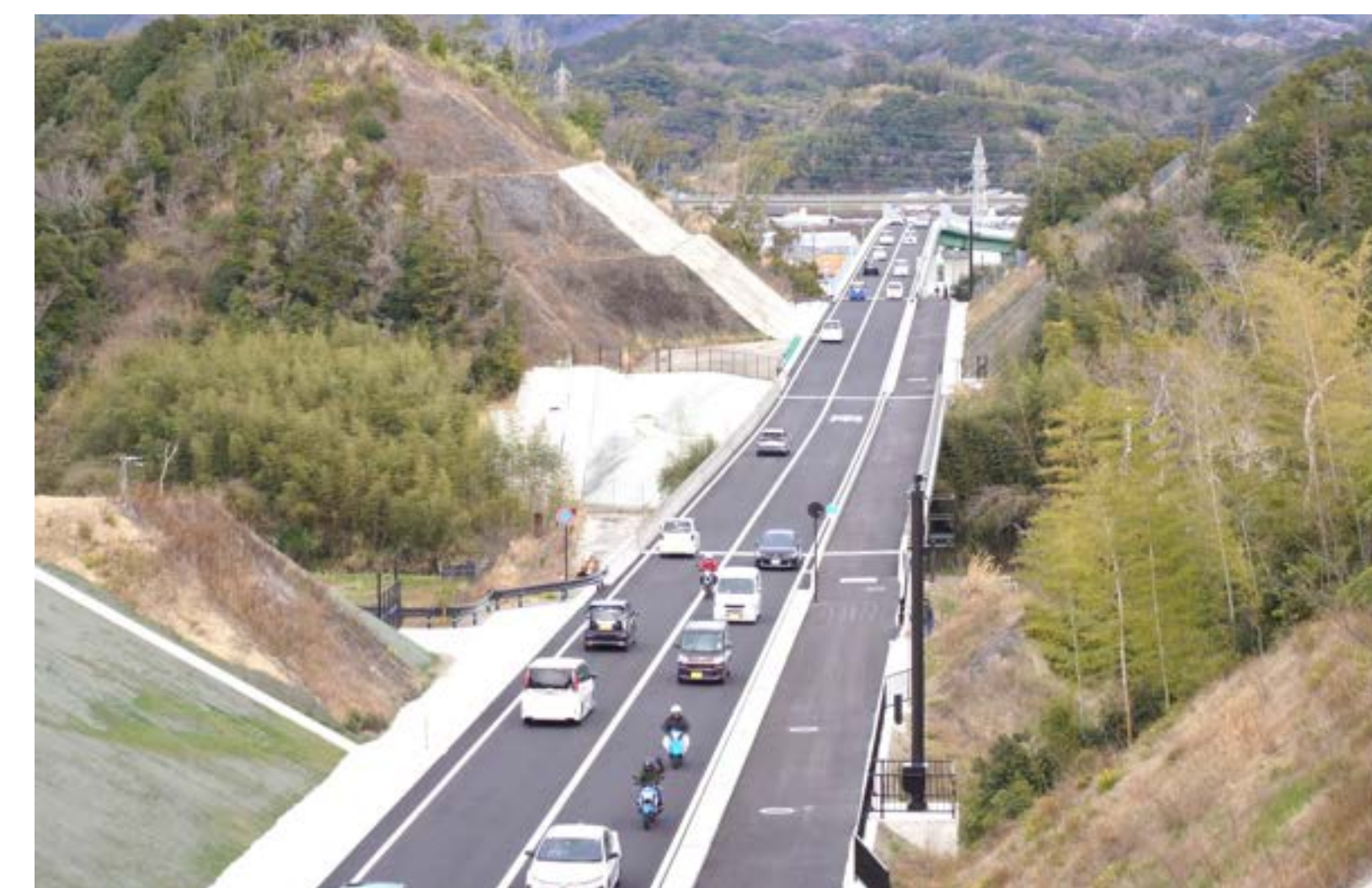
③ 【開通後】芳養町茨谷(茨谷高架橋)
