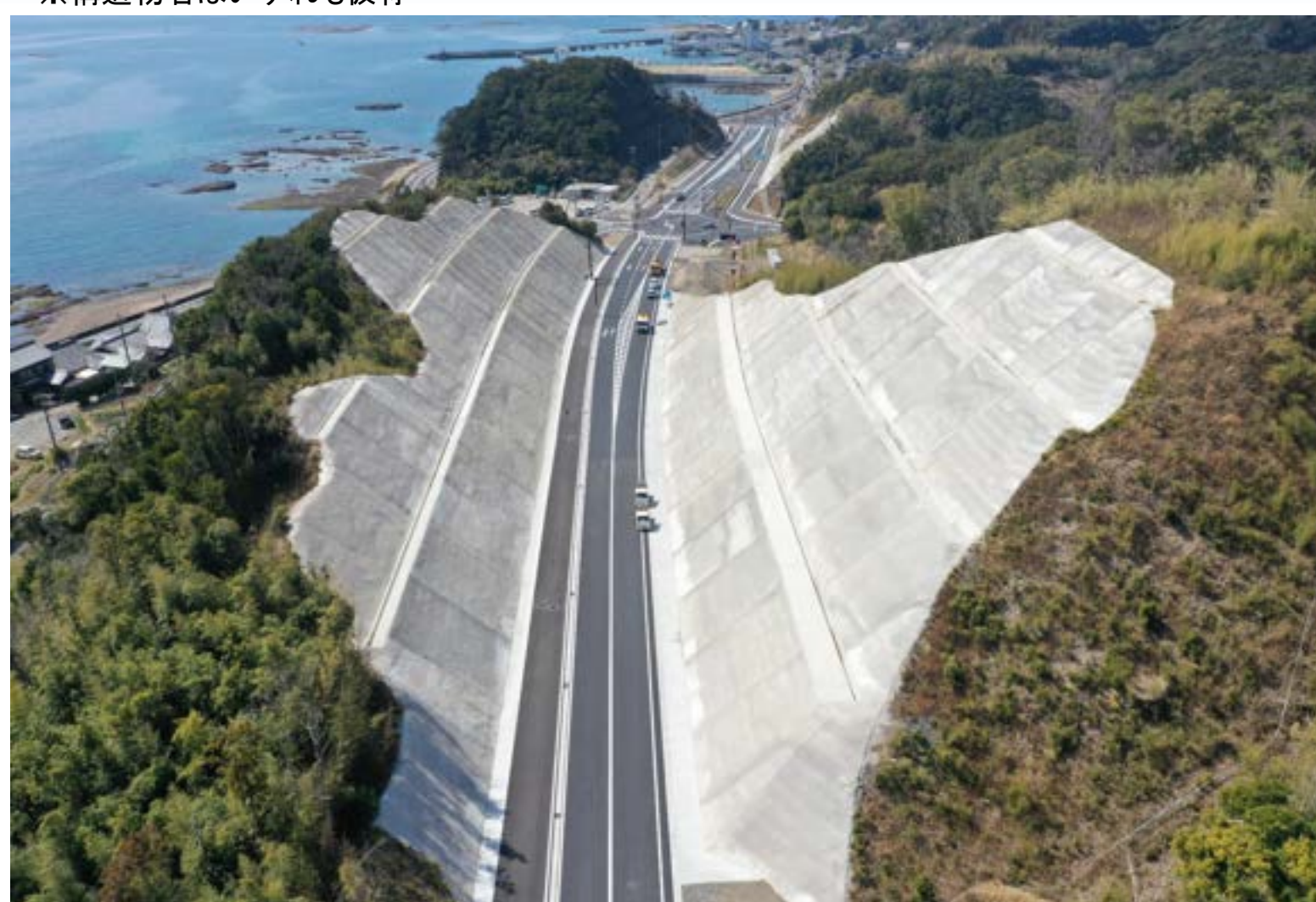
④ 芳養町小屋谷(道路改良)
