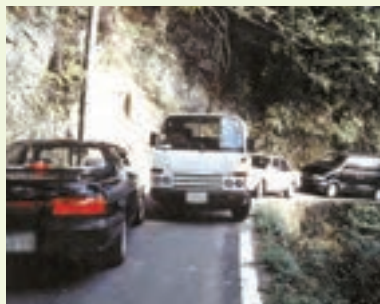
幅員が狭く、離合困難な国道169号の現状
