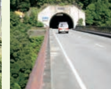
整備後の奥漣道路（有蔵トンネル付近）
