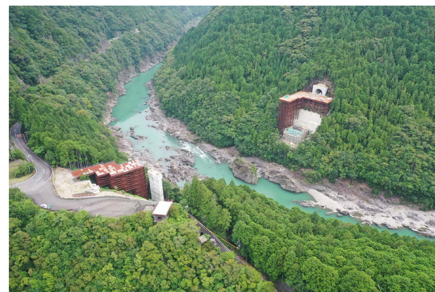
⑦ 北山村小松(2号トンネル・3号橋)
