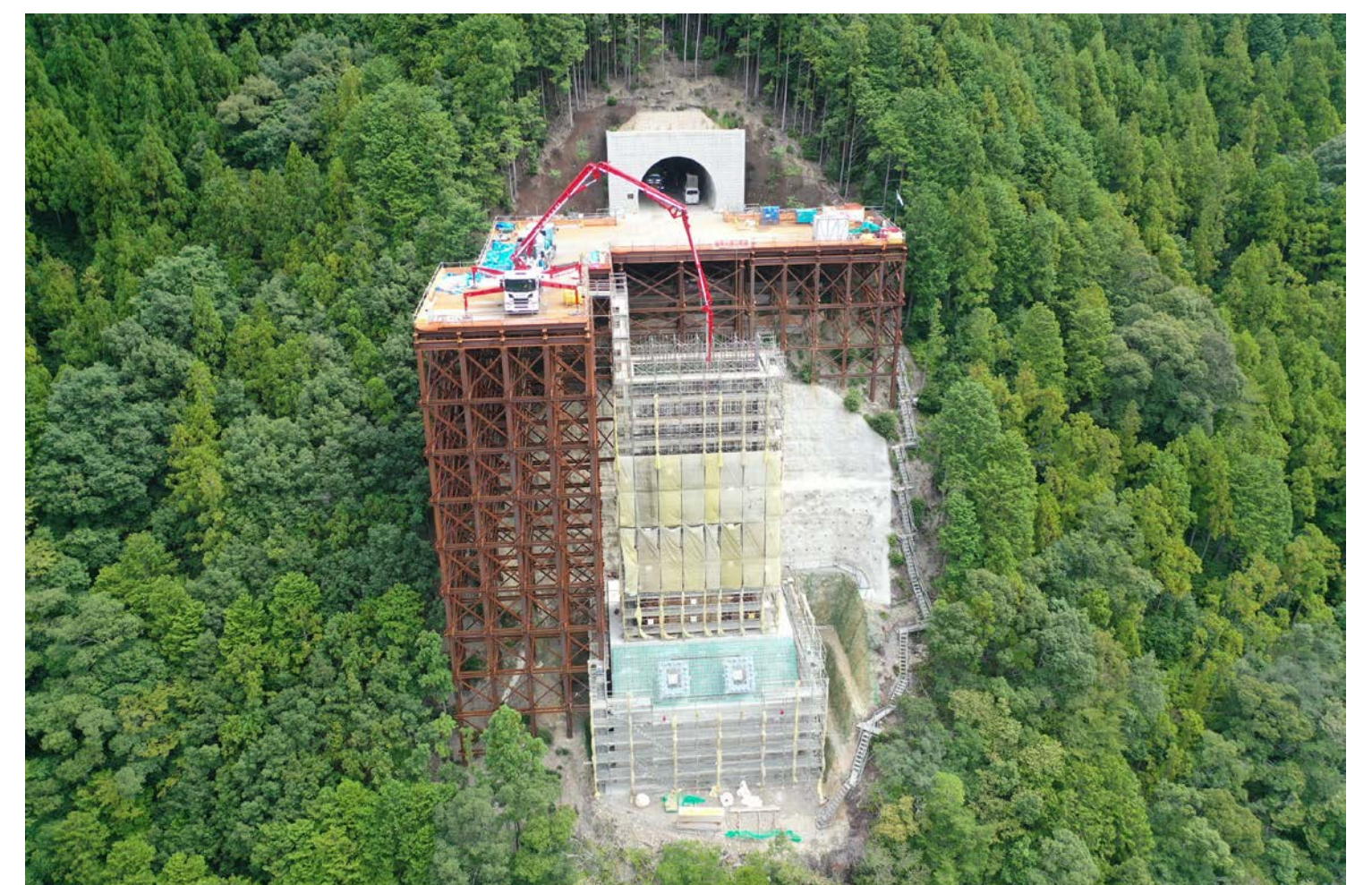
⑧ 北山村小松(2号トンネル・3号橋)
