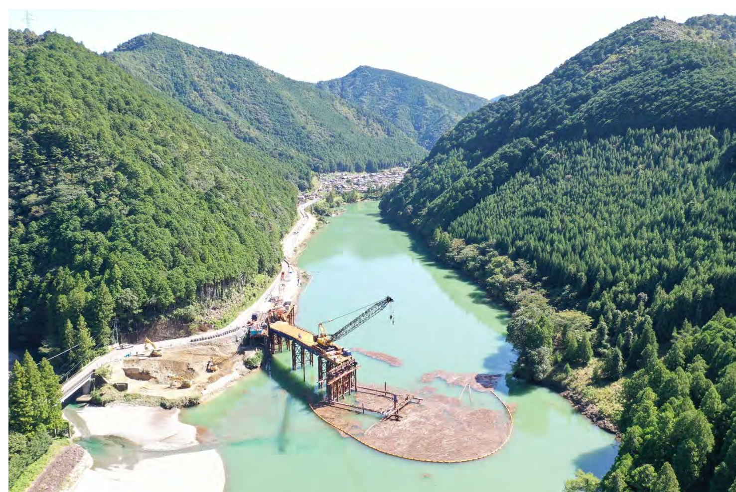
⑥ 1号トンネル他工事
