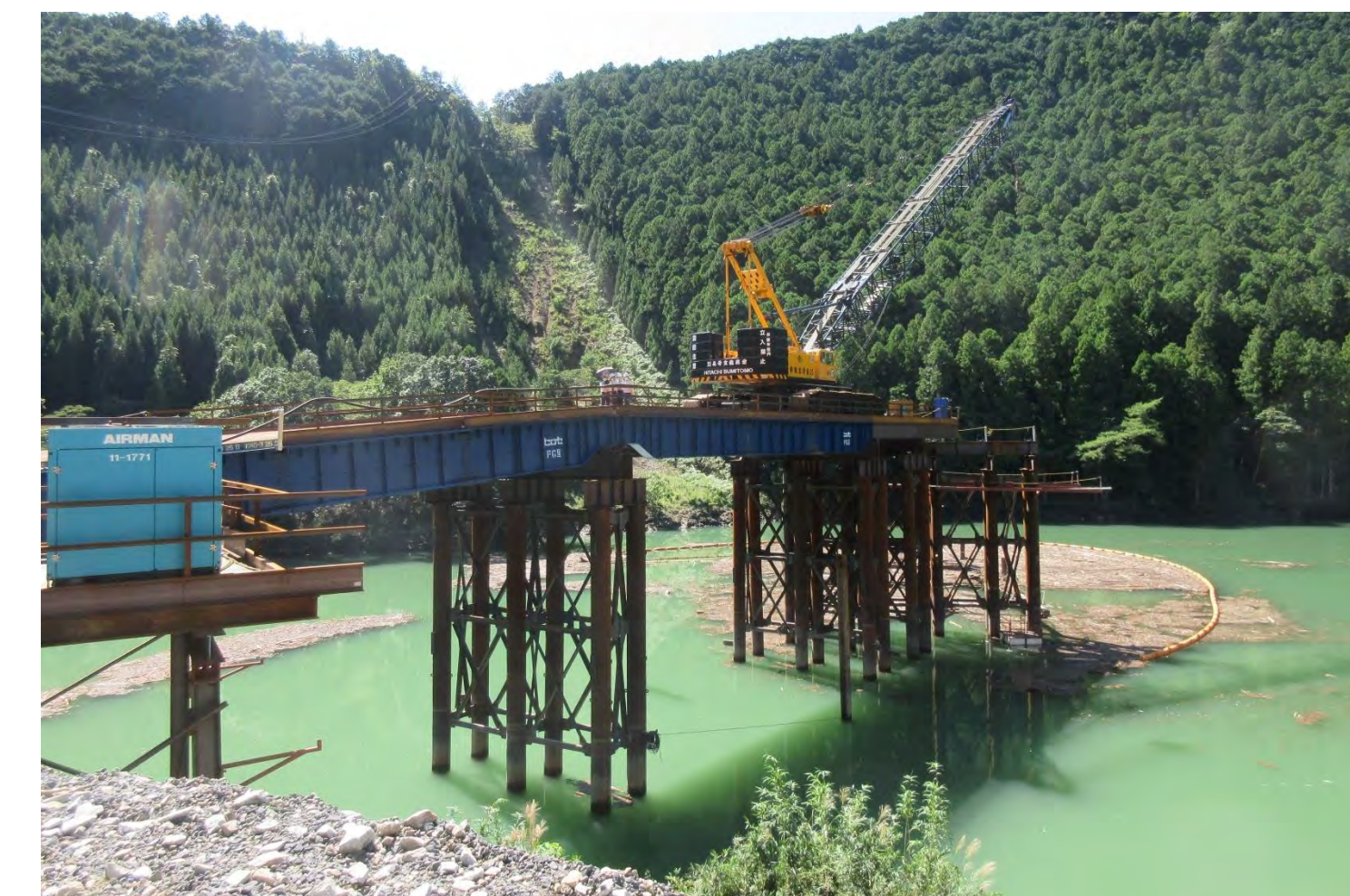
④ 1号トンネル他工事
