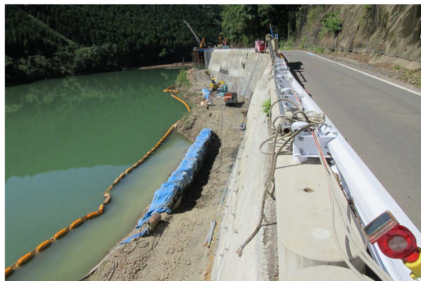
② 下尾井中地区他改良工事
