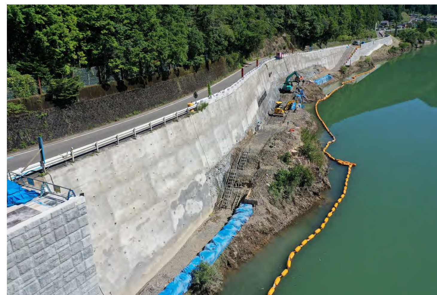
③ 下尾井中地区他改良工事
