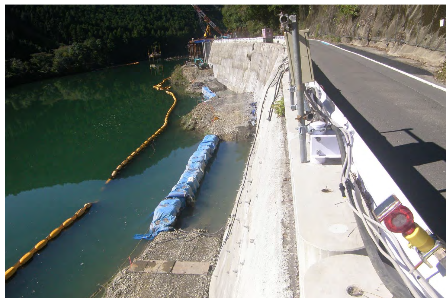
② 下尾井中地区他改良工事
