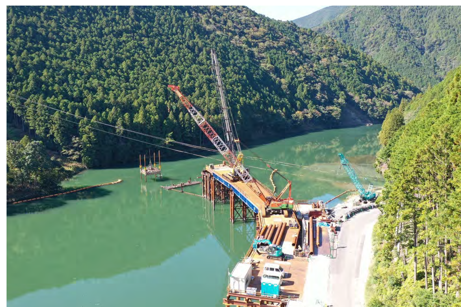
⑤ 1号トンネル他工事
