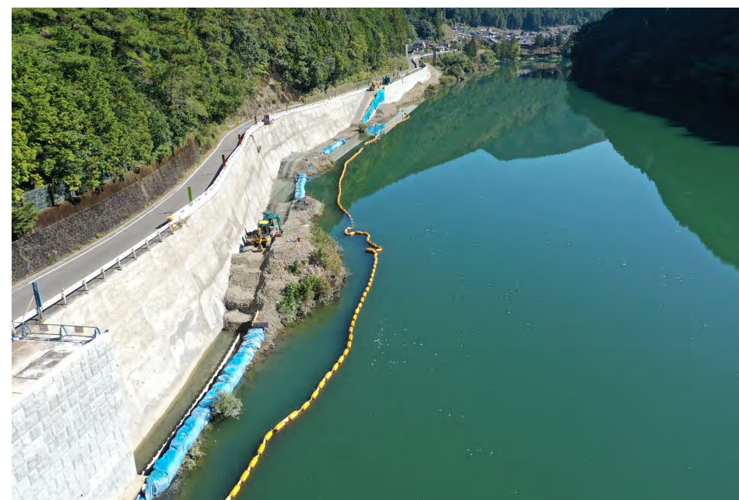
③ 下尾井中地区他改良工事
