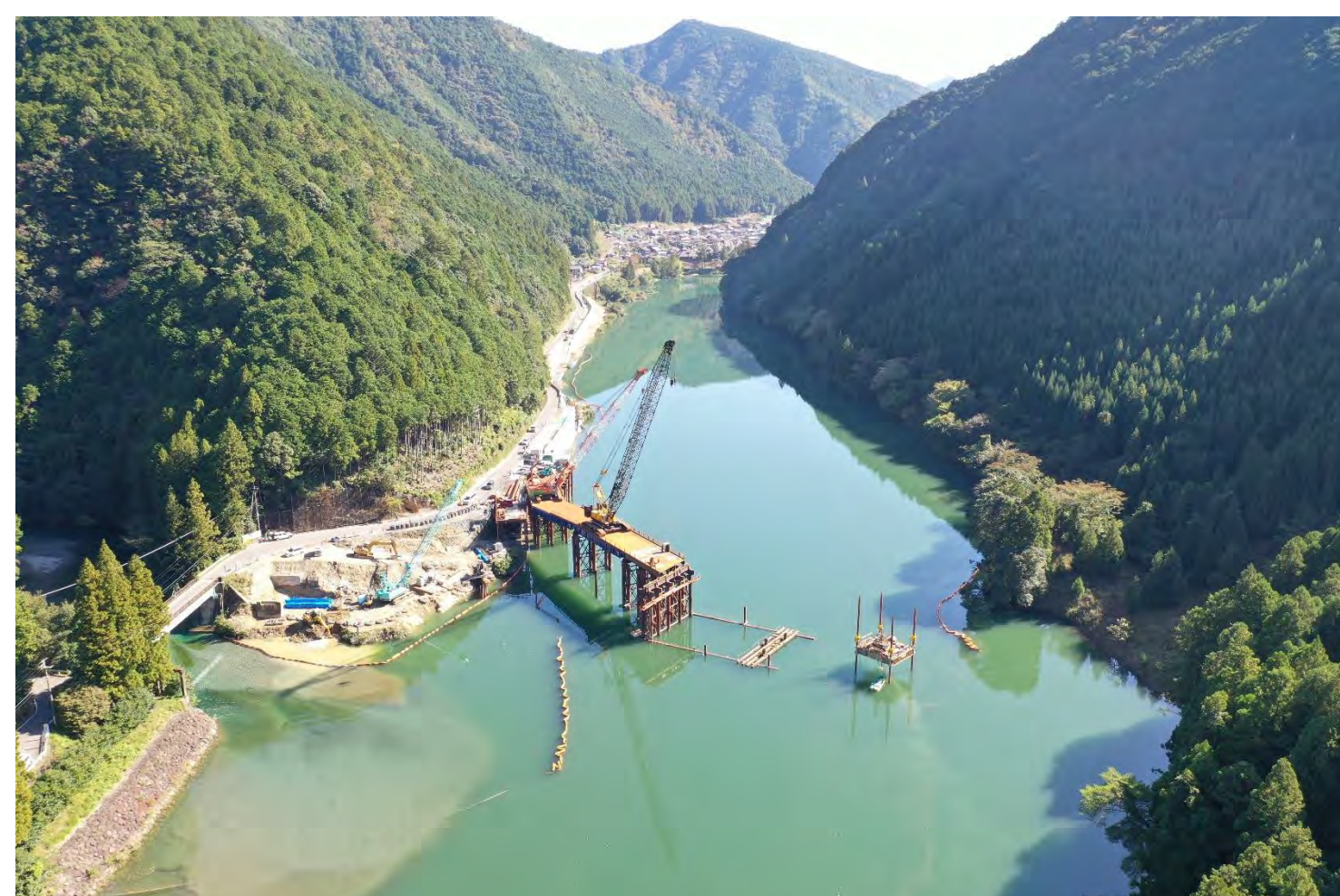
⑥ 1号トンネル他工事
