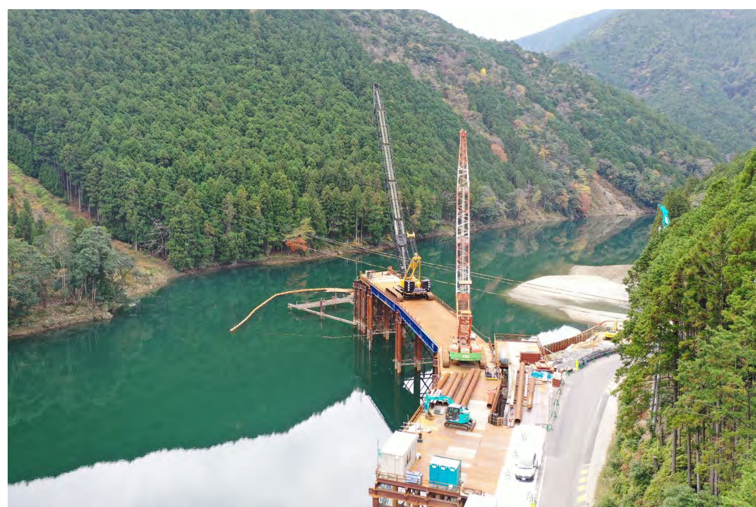
⑤ 1号トンネル他工事
