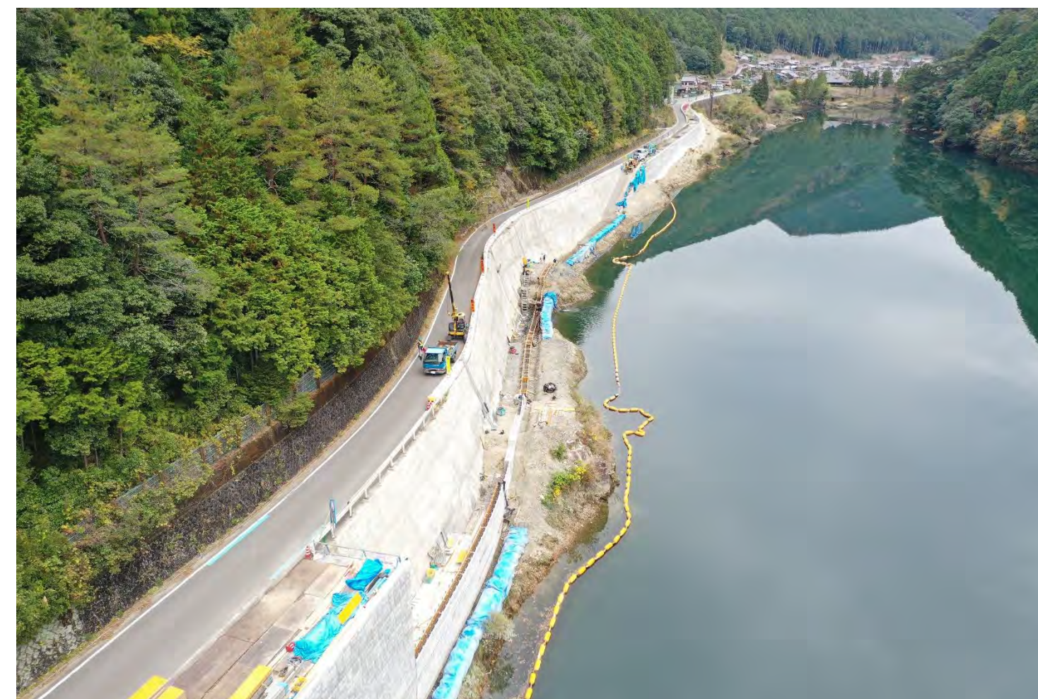
③ 下尾井中地区他改良工事
