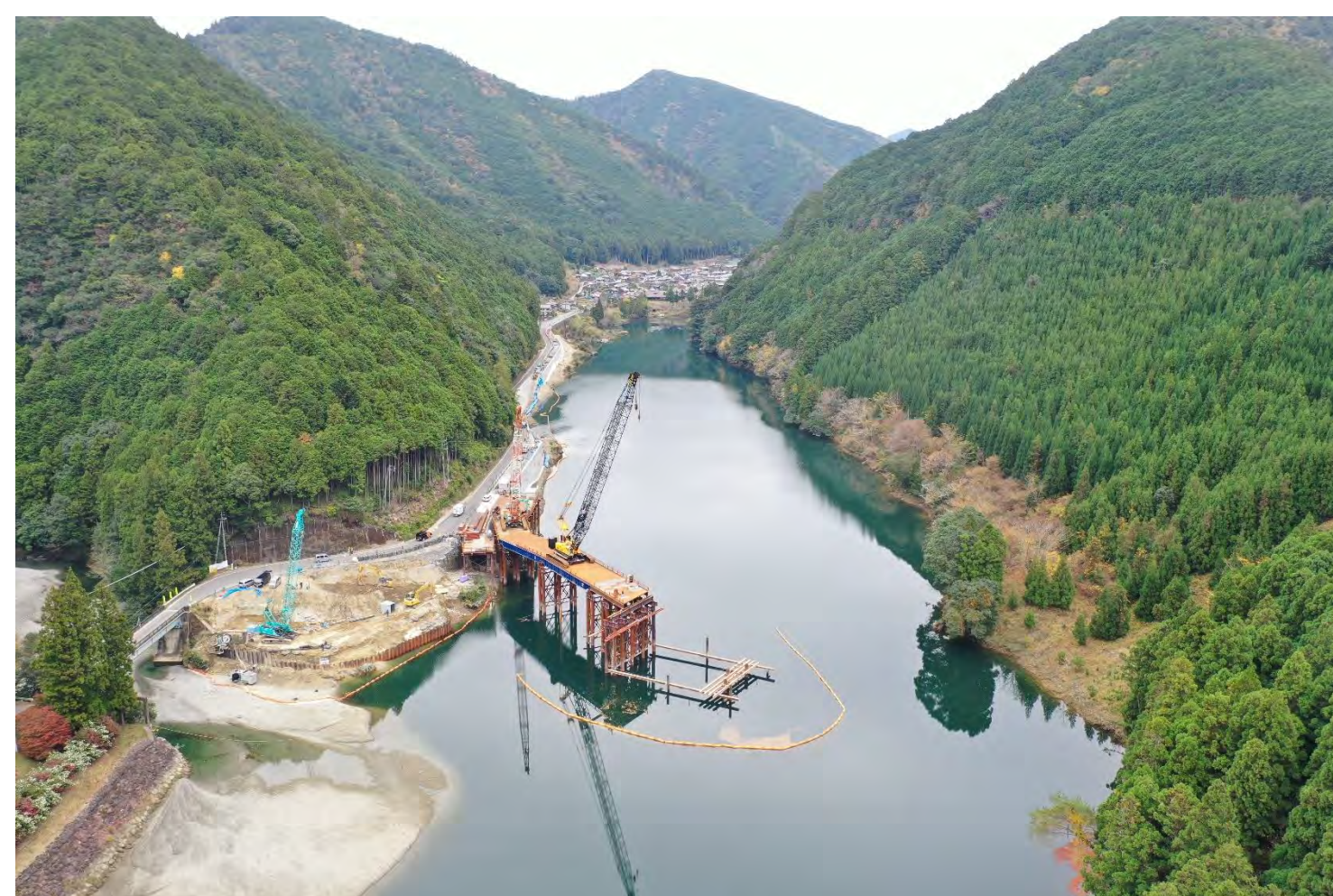
⑥ 1号トンネル他工事
