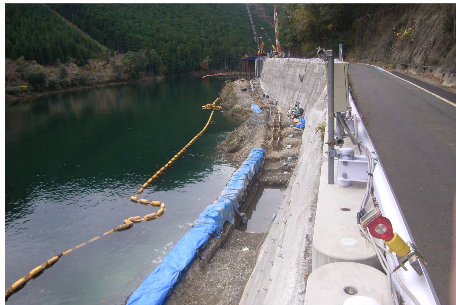
② 下尾井中地区他改良工事
