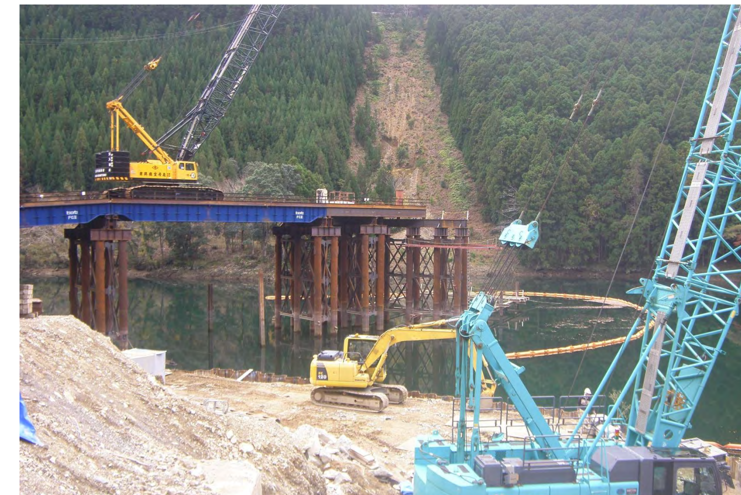
④ 1号トンネル他工事
