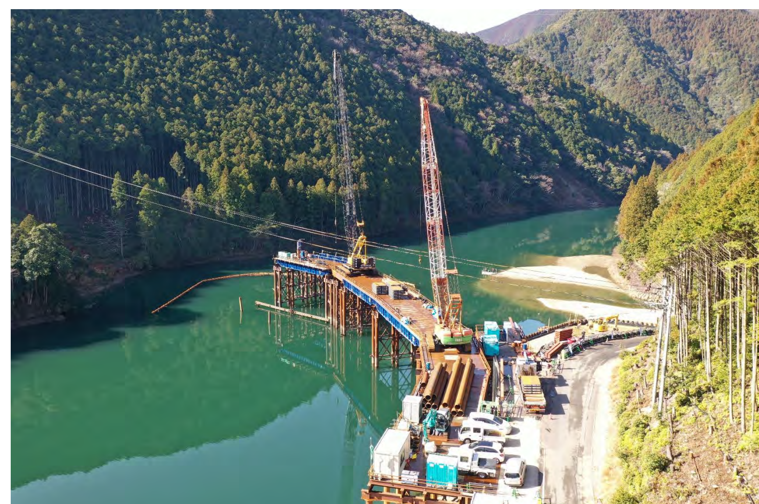
⑤ 1号トンネル他工事
