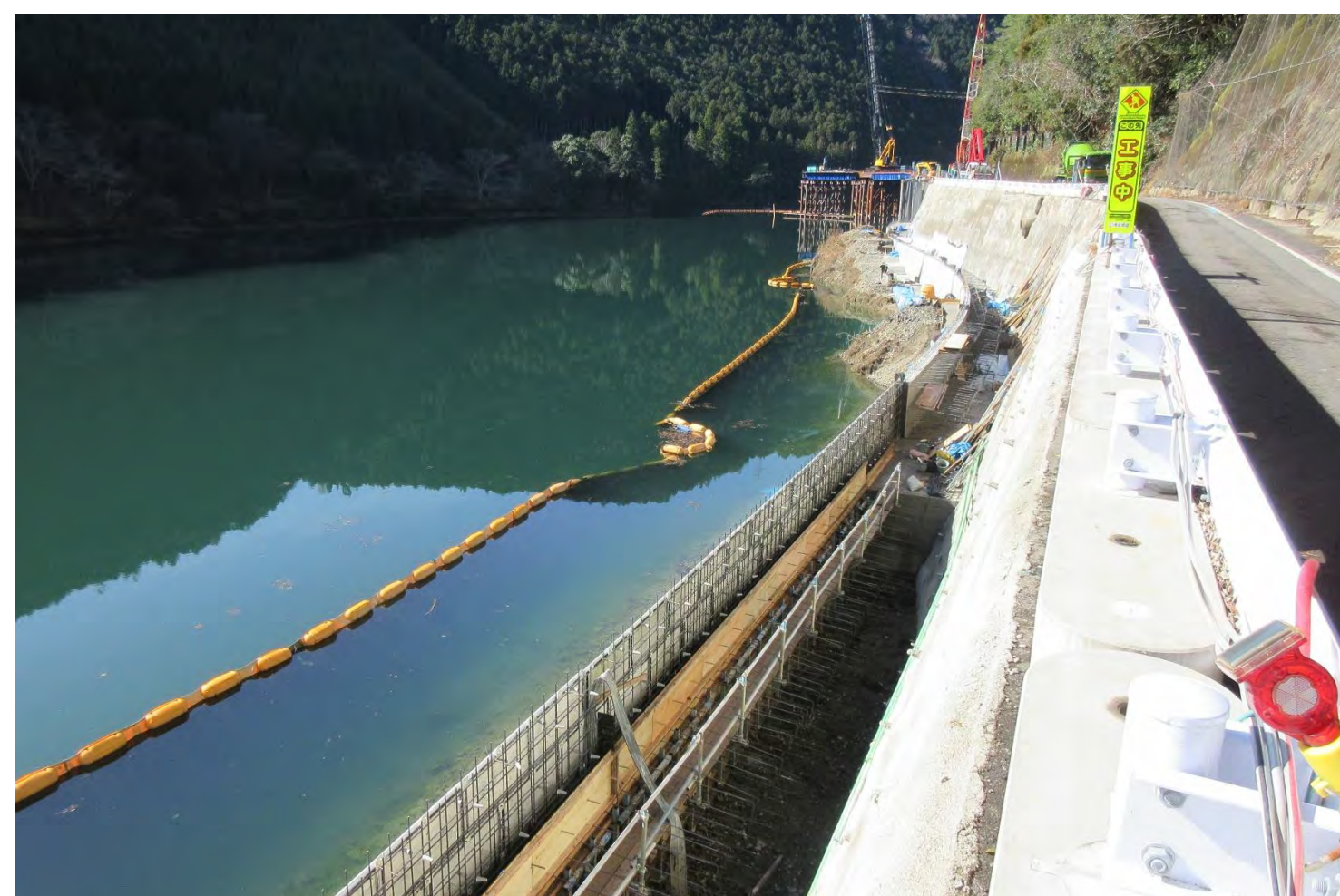
② 下尾井中地区他改良工事
