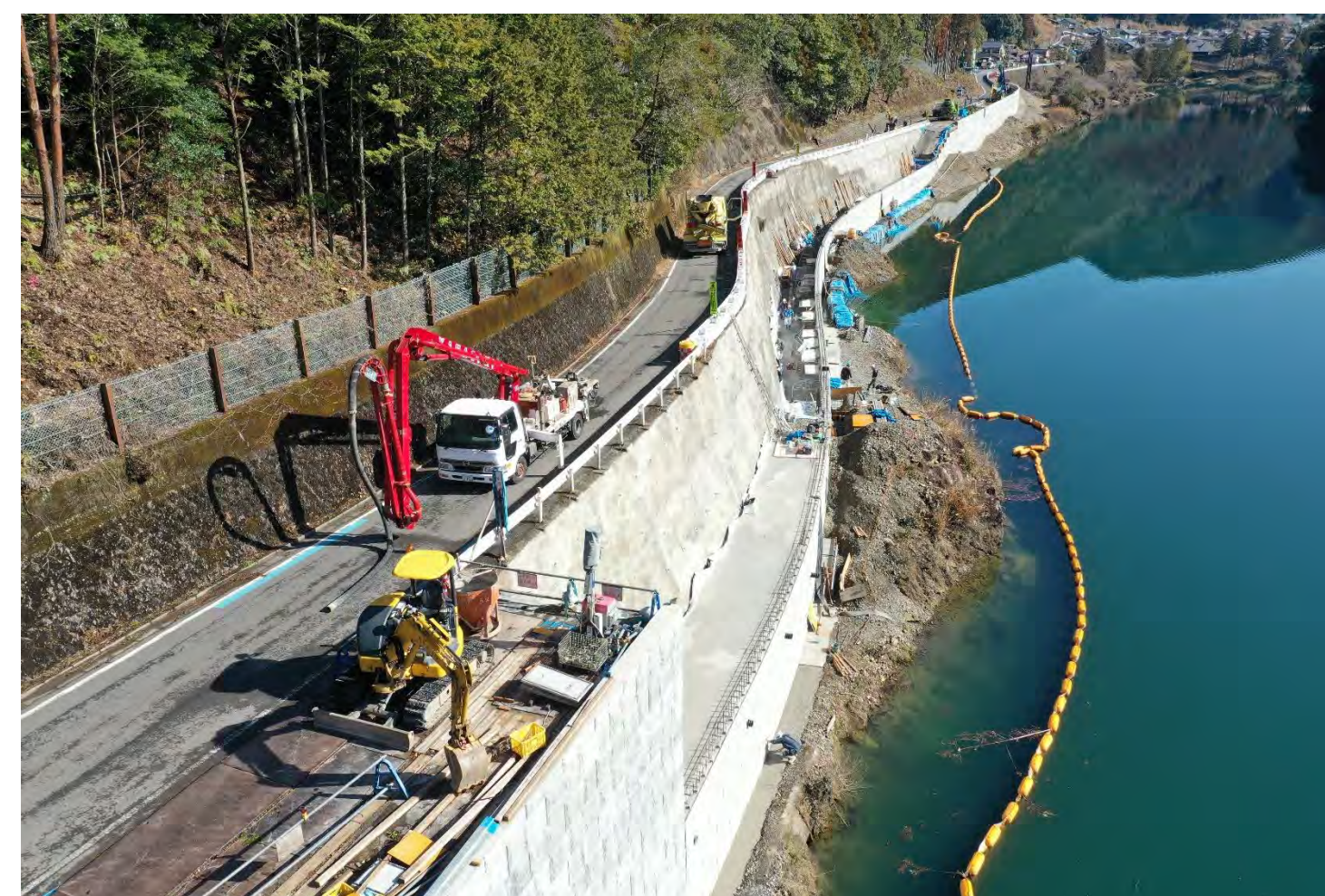
③ 下尾井中地区他改良工事
