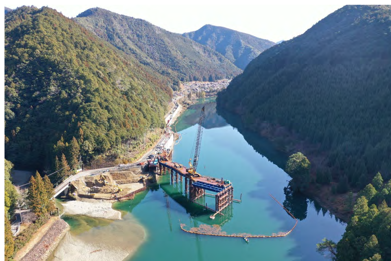
⑥ 1号トンネル他工事
