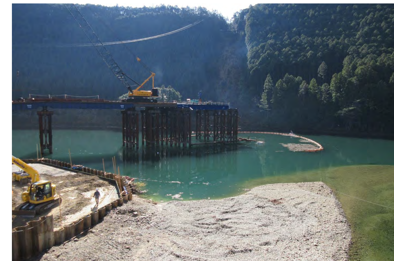
④ 1号トンネル他工事
