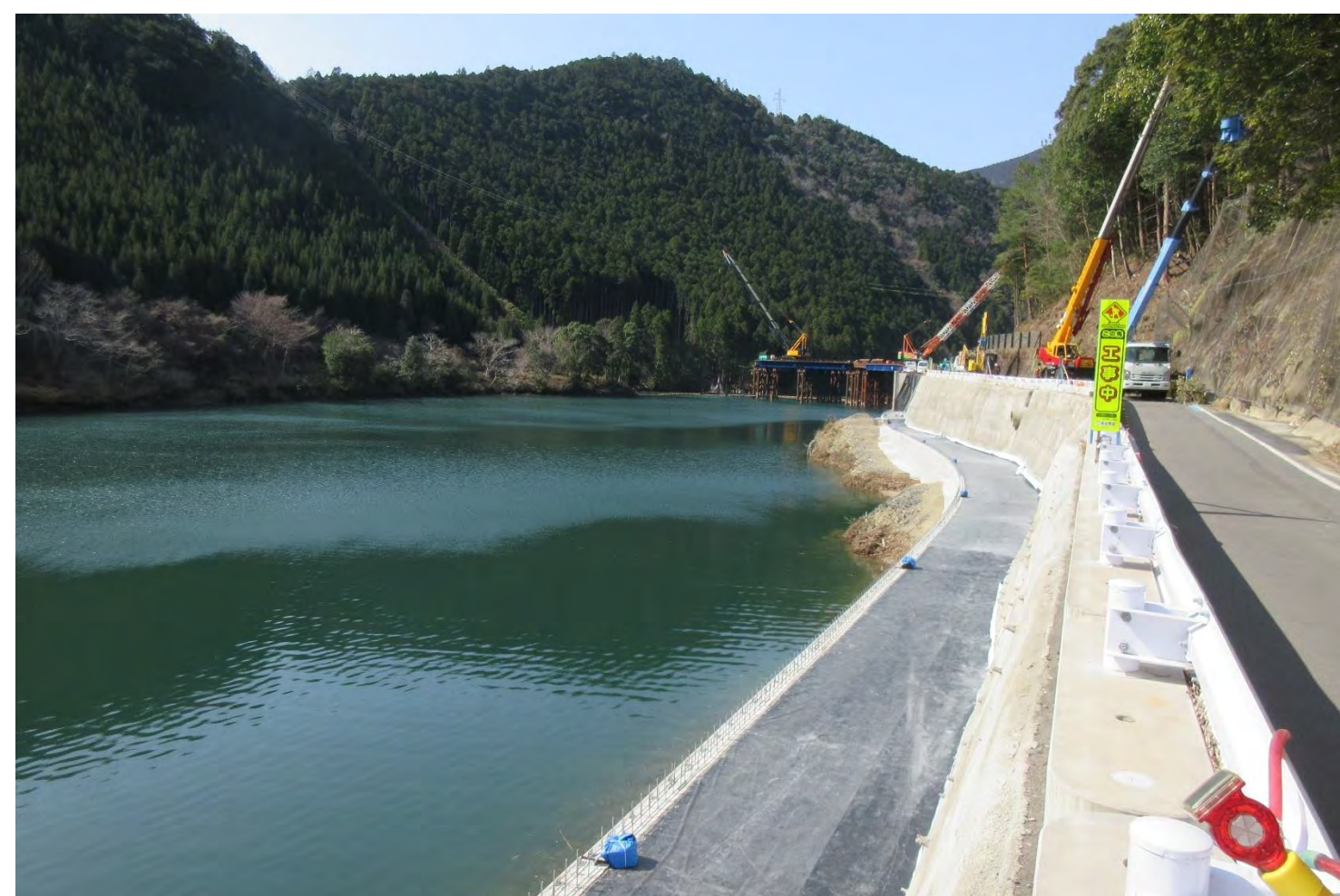
② 下尾井中地区他改良工事(令和3年2月26日完了)
