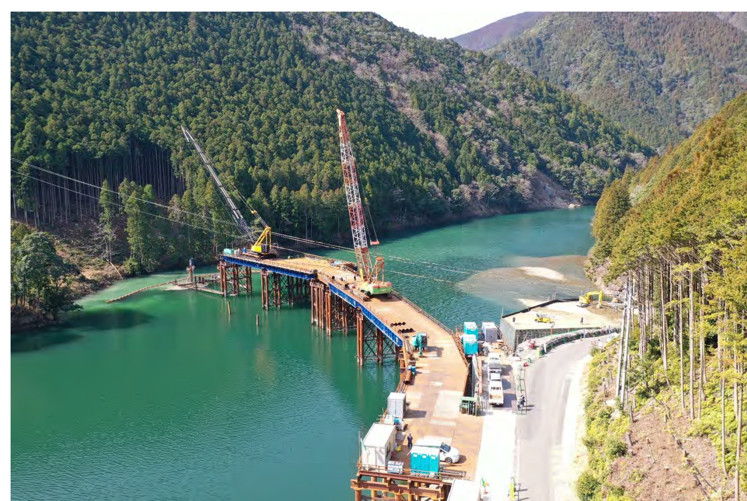
⑤ 1号トンネル他工事
