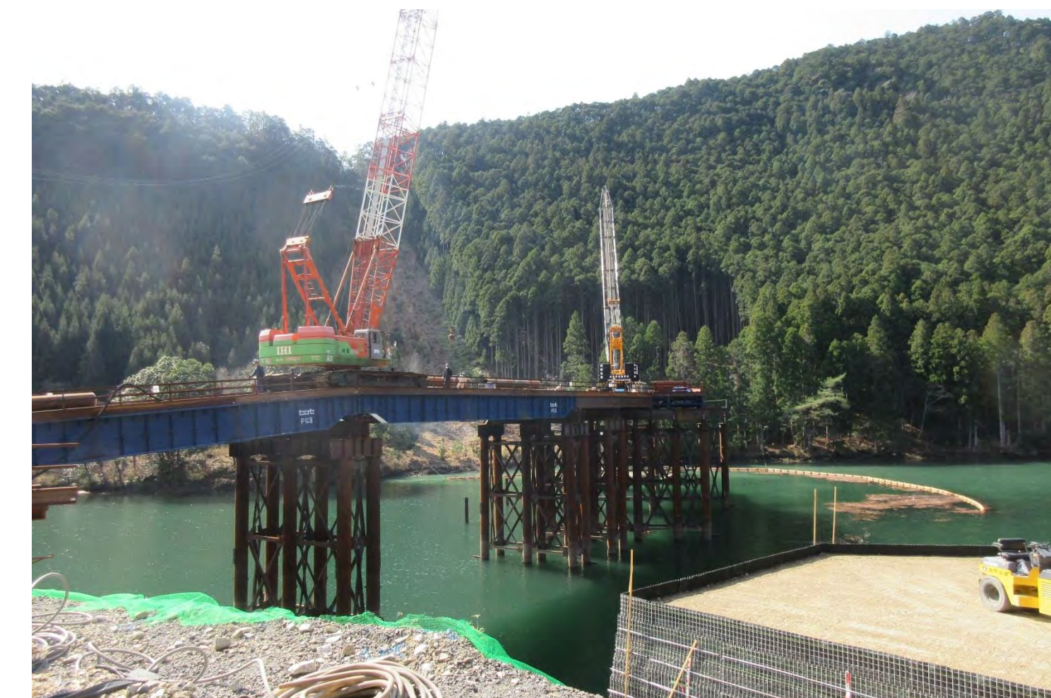
④ 1号トンネル他工事
