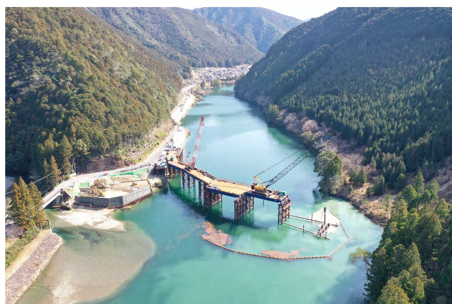
⑥ 1号トンネル他工事
