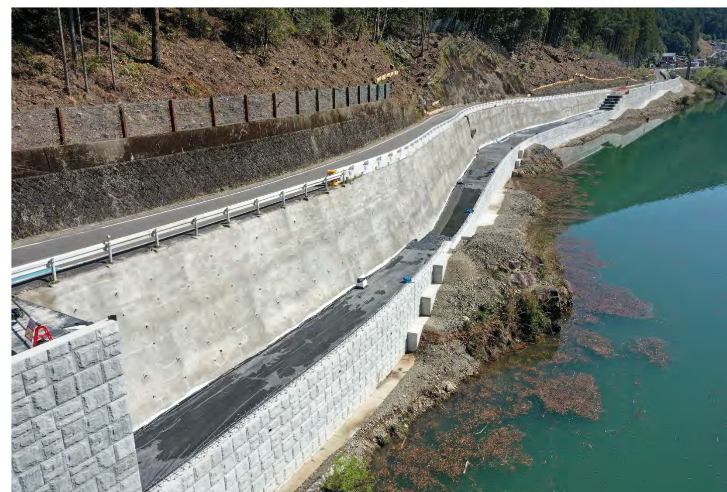
③ 下尾井中地区他改良工事(令和3年2月26日完了)
