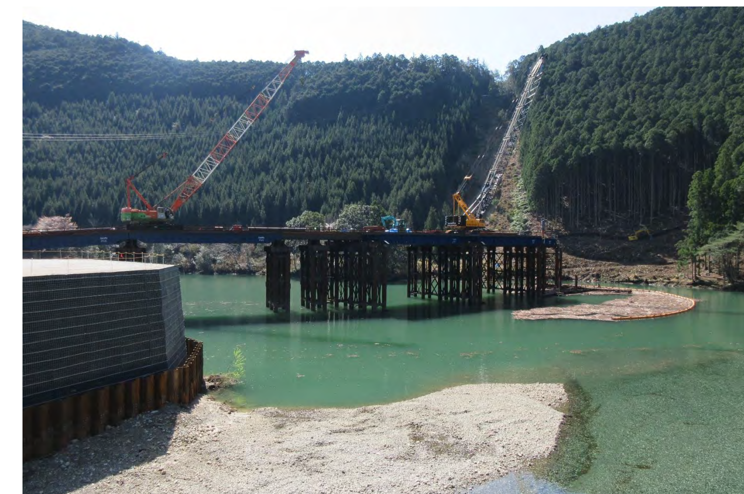
④ 1号トンネル他工事
