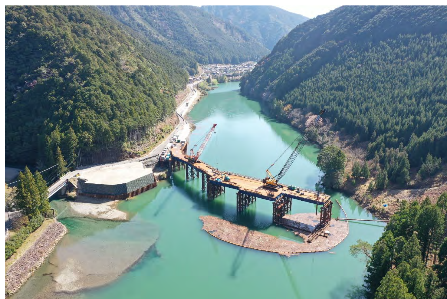
⑥ 1号トンネル他工事
