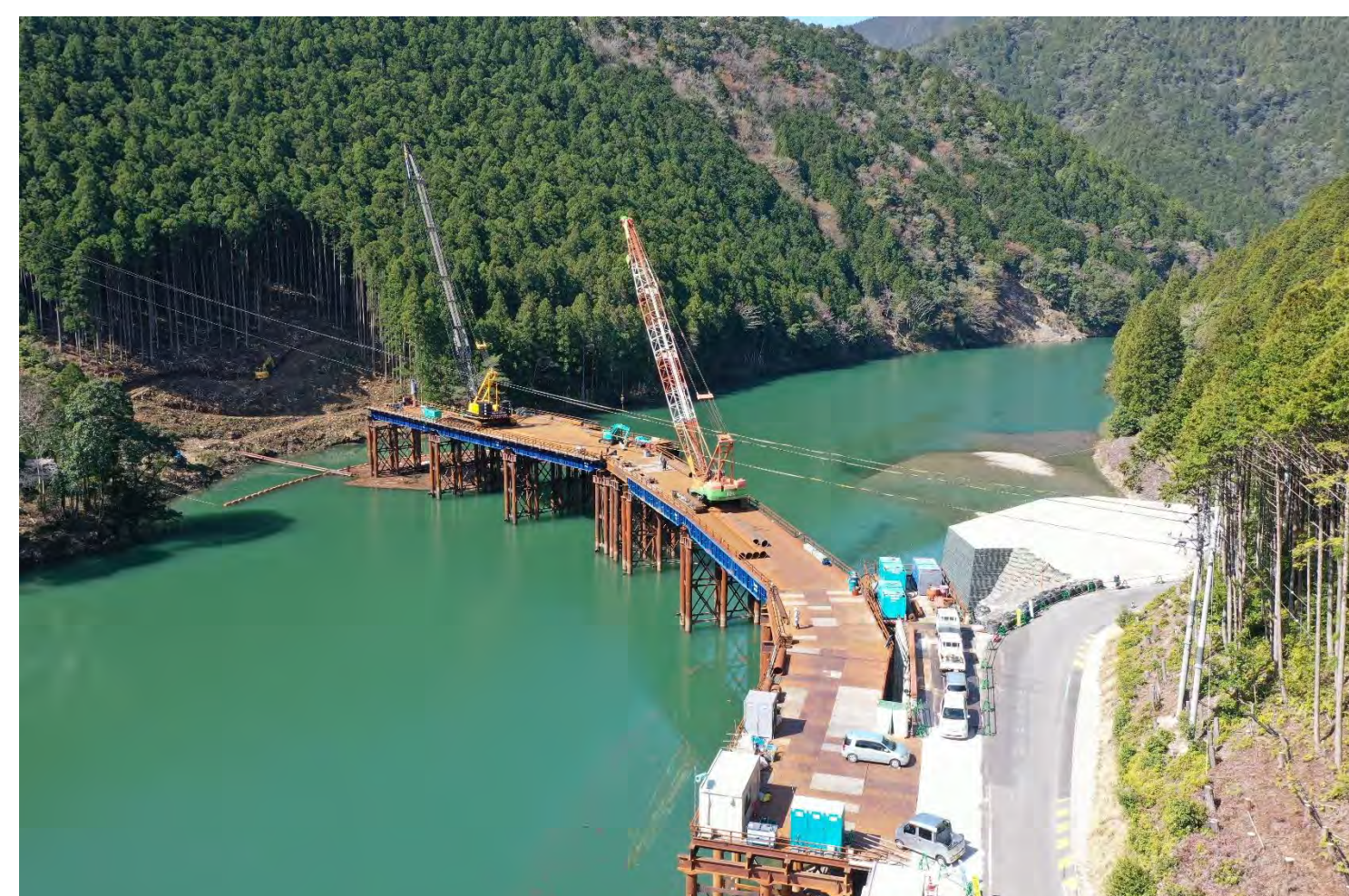
⑤ 1号トンネル他工事
