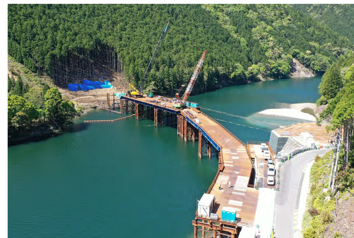
⑤ 1号トンネル他工事
