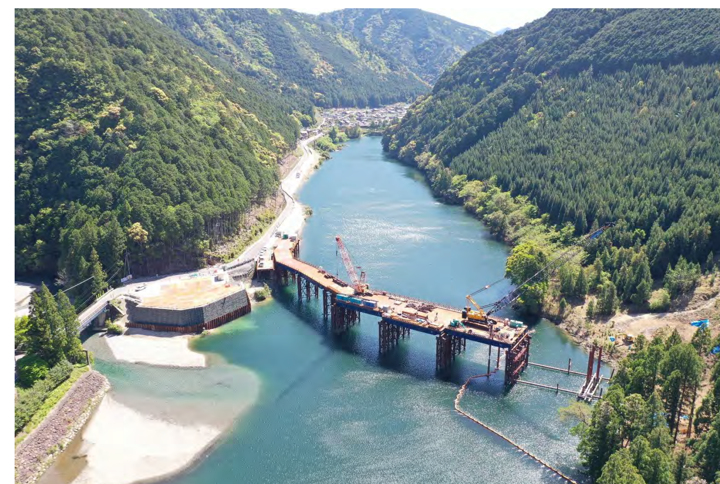
⑥ 1号トンネル他工事
