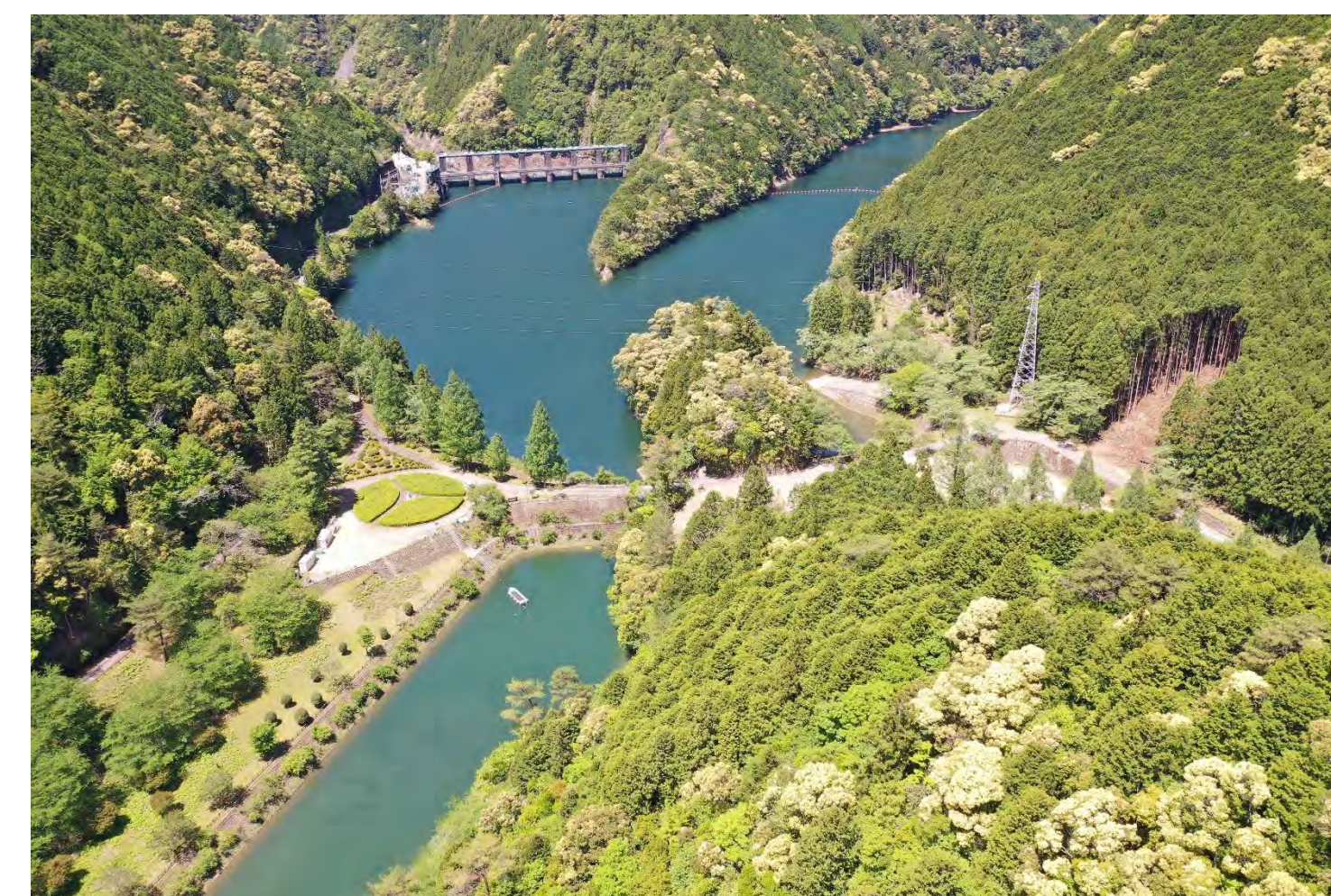
⑦ 2号トンネル他工事
