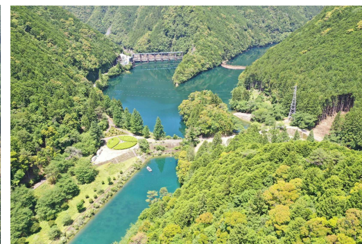
⑦ 2号トンネル他工事
