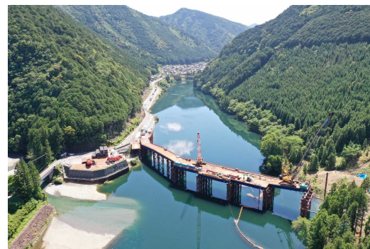
⑥ 1号トンネル他工事
