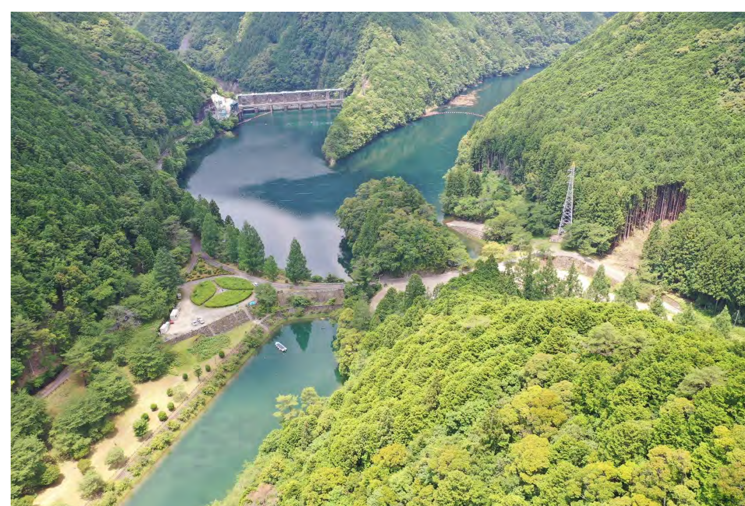
⑦ 2号トンネル他工事
