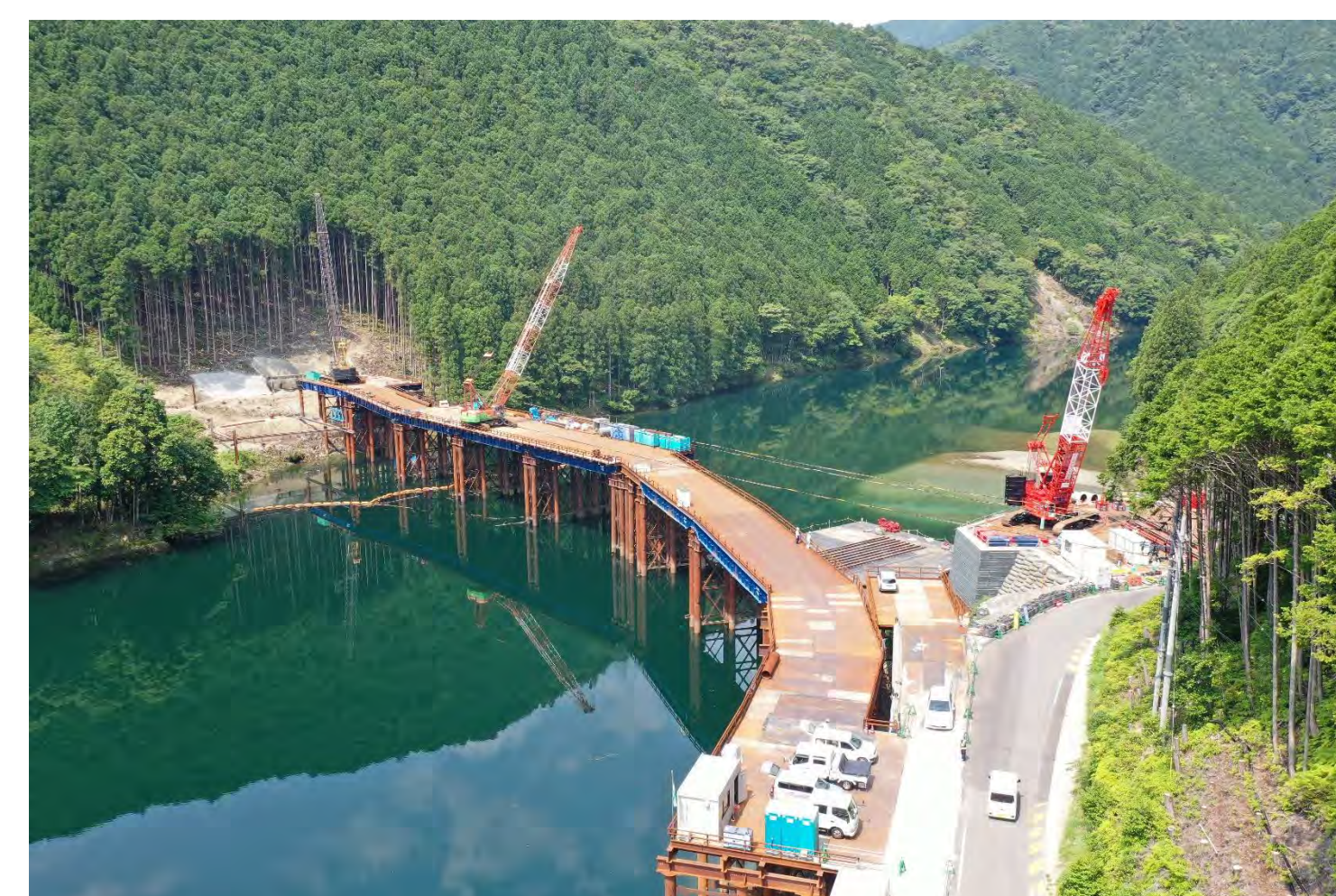
⑤ 1号トンネル他工事
