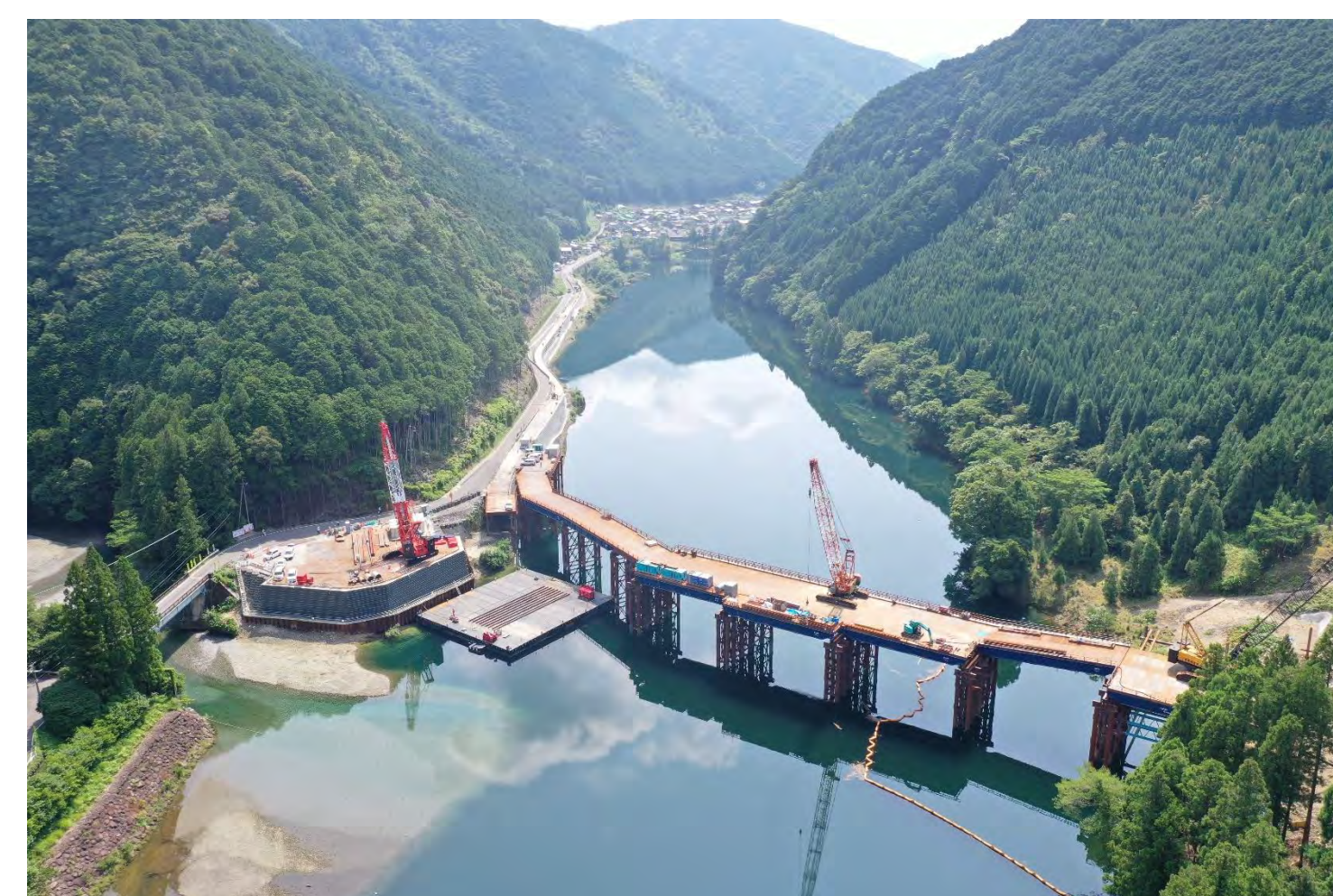
⑥ 1号トンネル他工事
