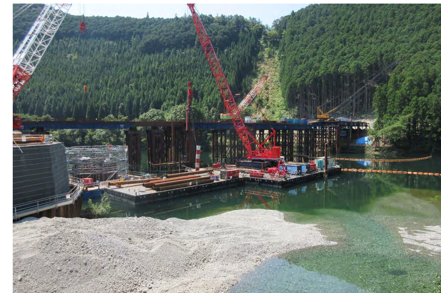
④ 1号トンネル他工事
