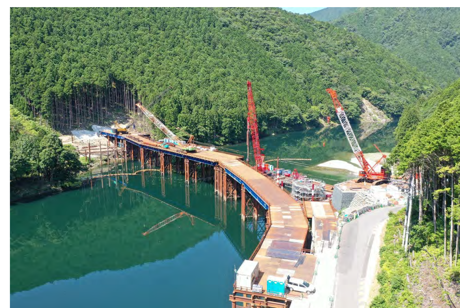
⑤ 1号トンネル他工事
