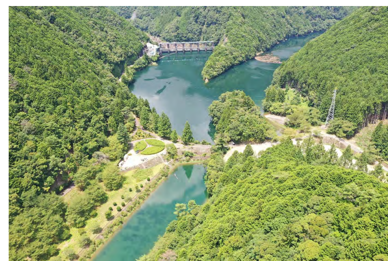
⑦ 2号トンネル他工事
