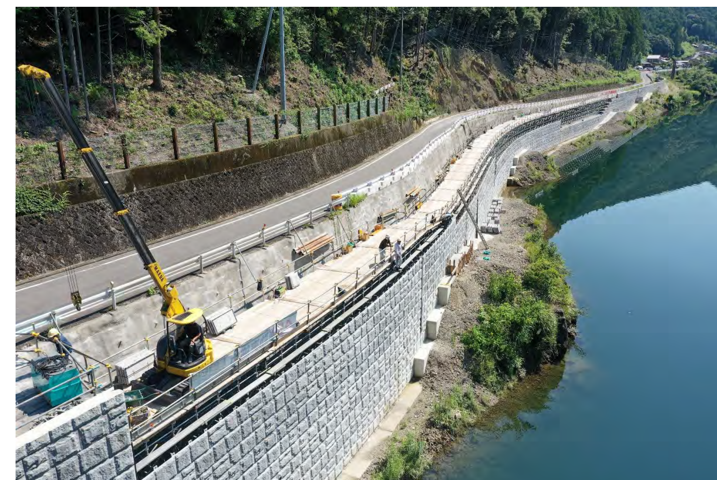
③ 下尾井北地区他改良工事(令和3年2月26日完了)
