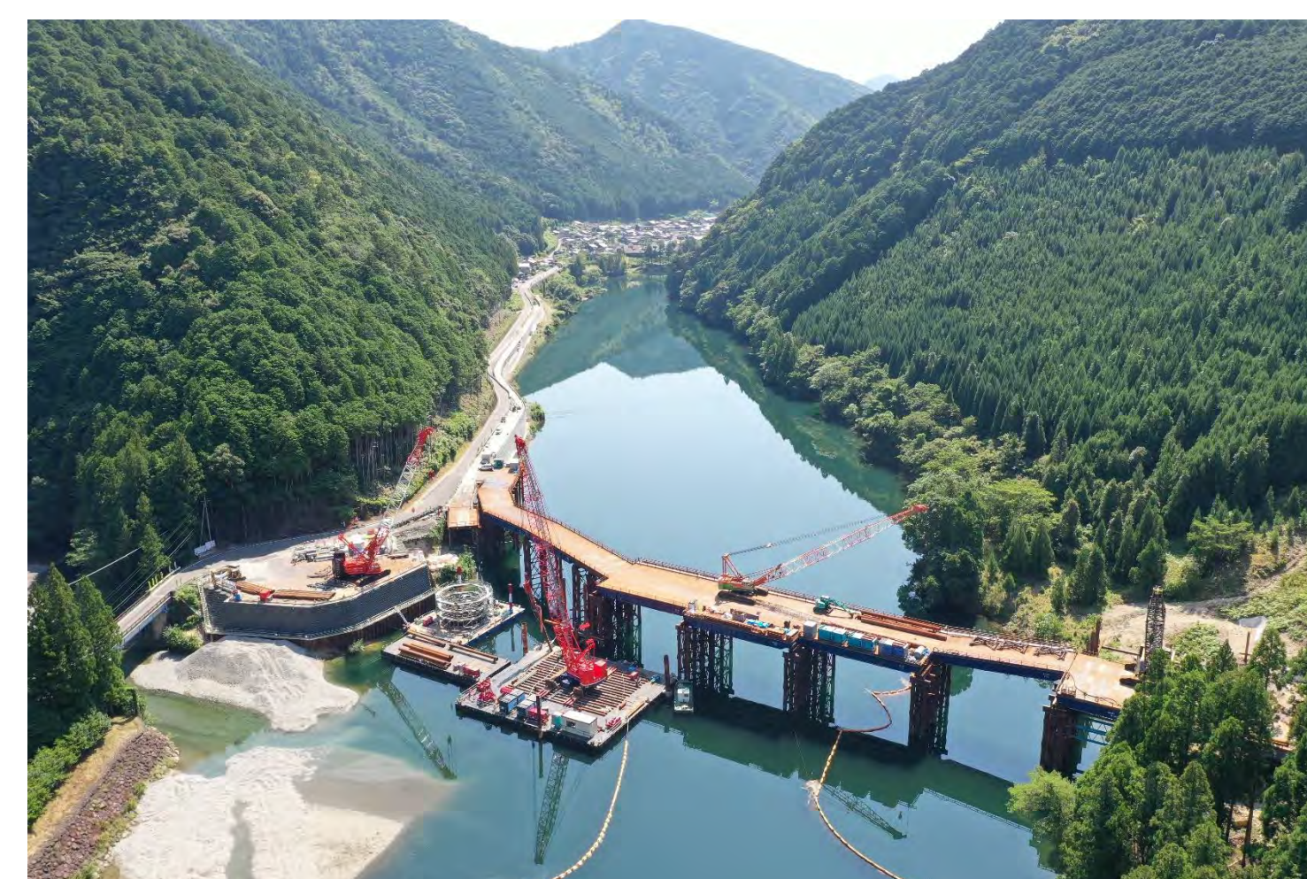
⑥ 1号トンネル他工事
