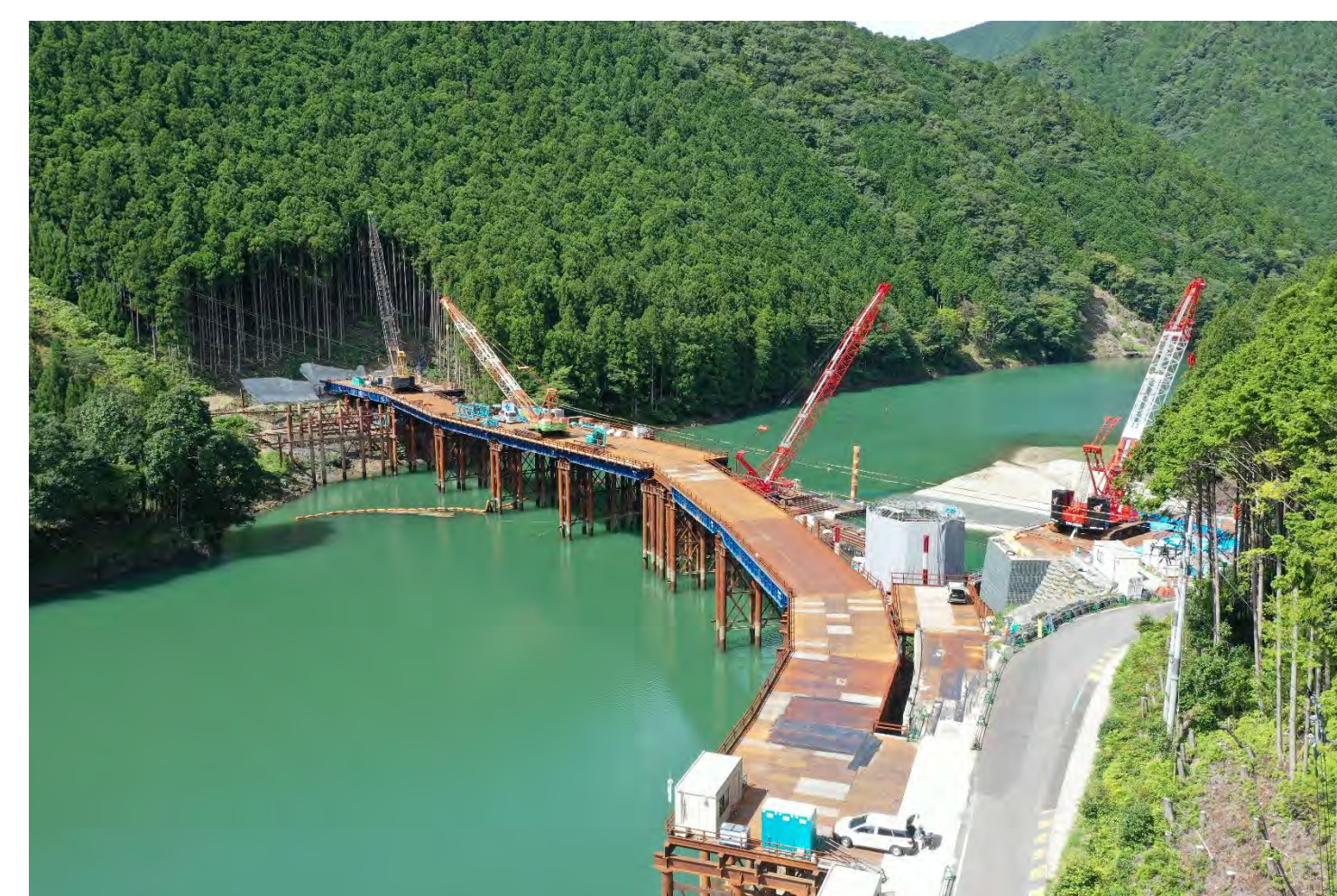
⑤ 1号トンネル他工事
