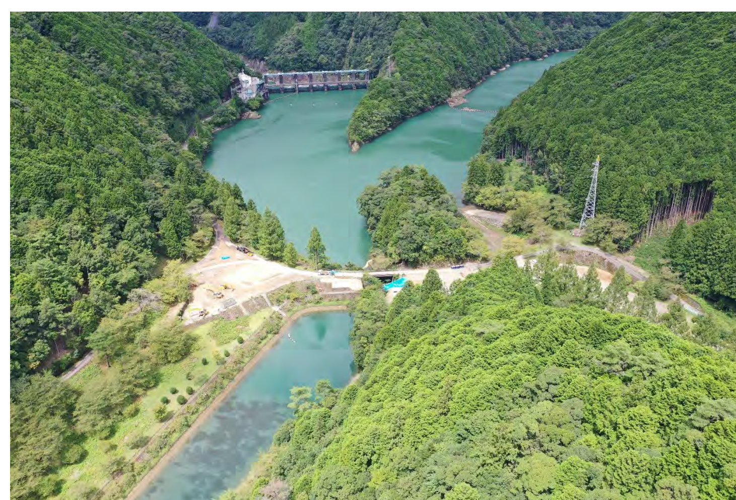
⑦ 2号トンネル他工事
