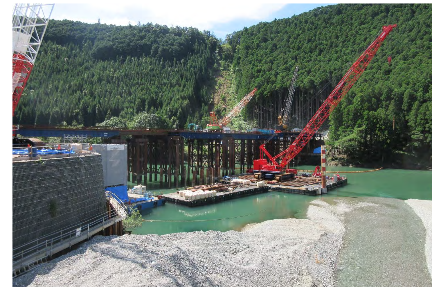
④ 1号トンネル他工事
