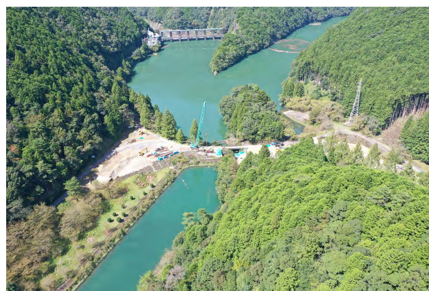
⑦ 2号トンネル他工事
