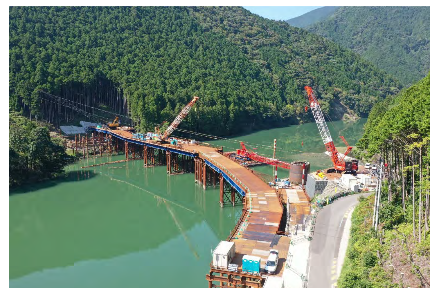
⑤ 1号トンネル他工事
