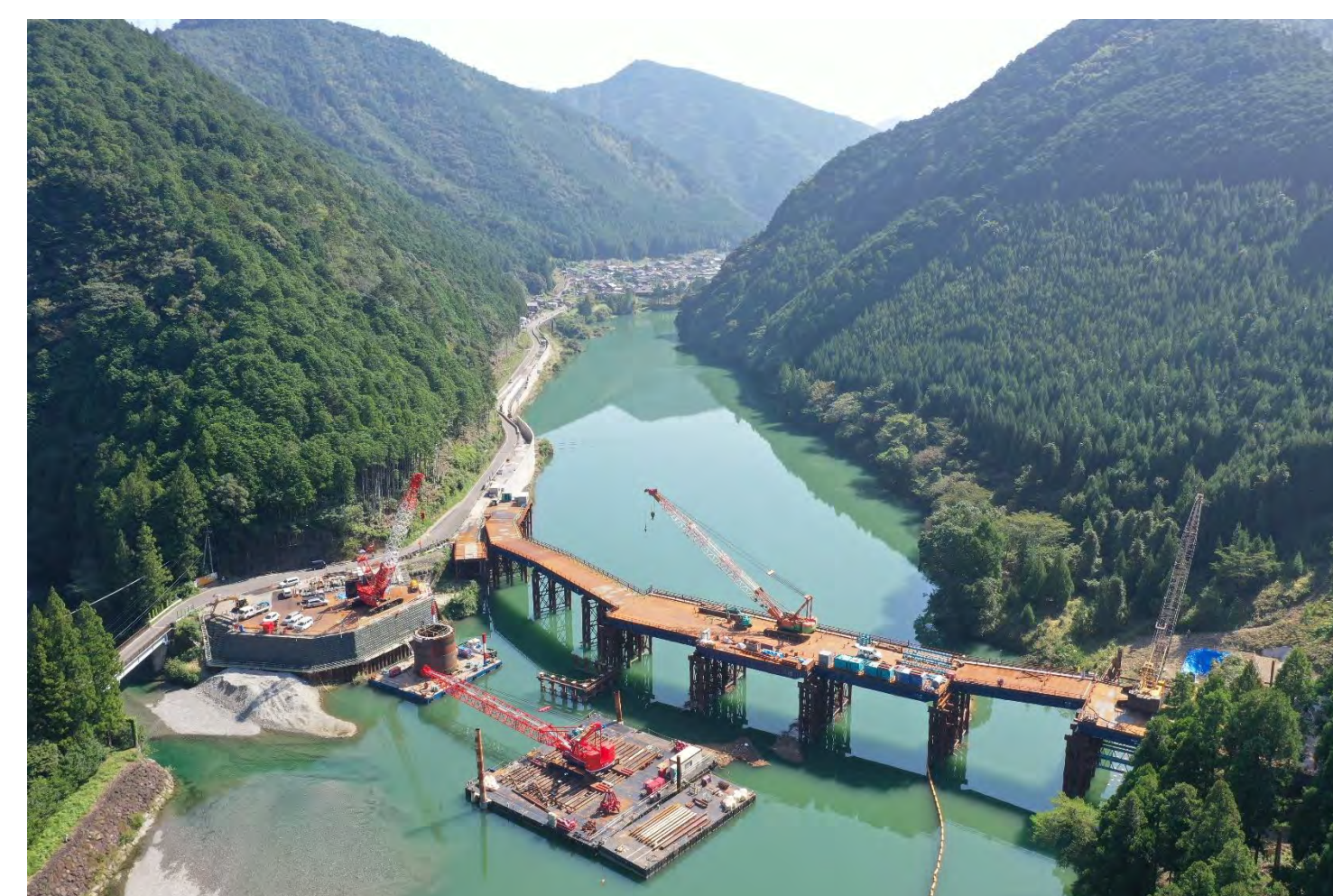
⑥ 1号トンネル他工事
