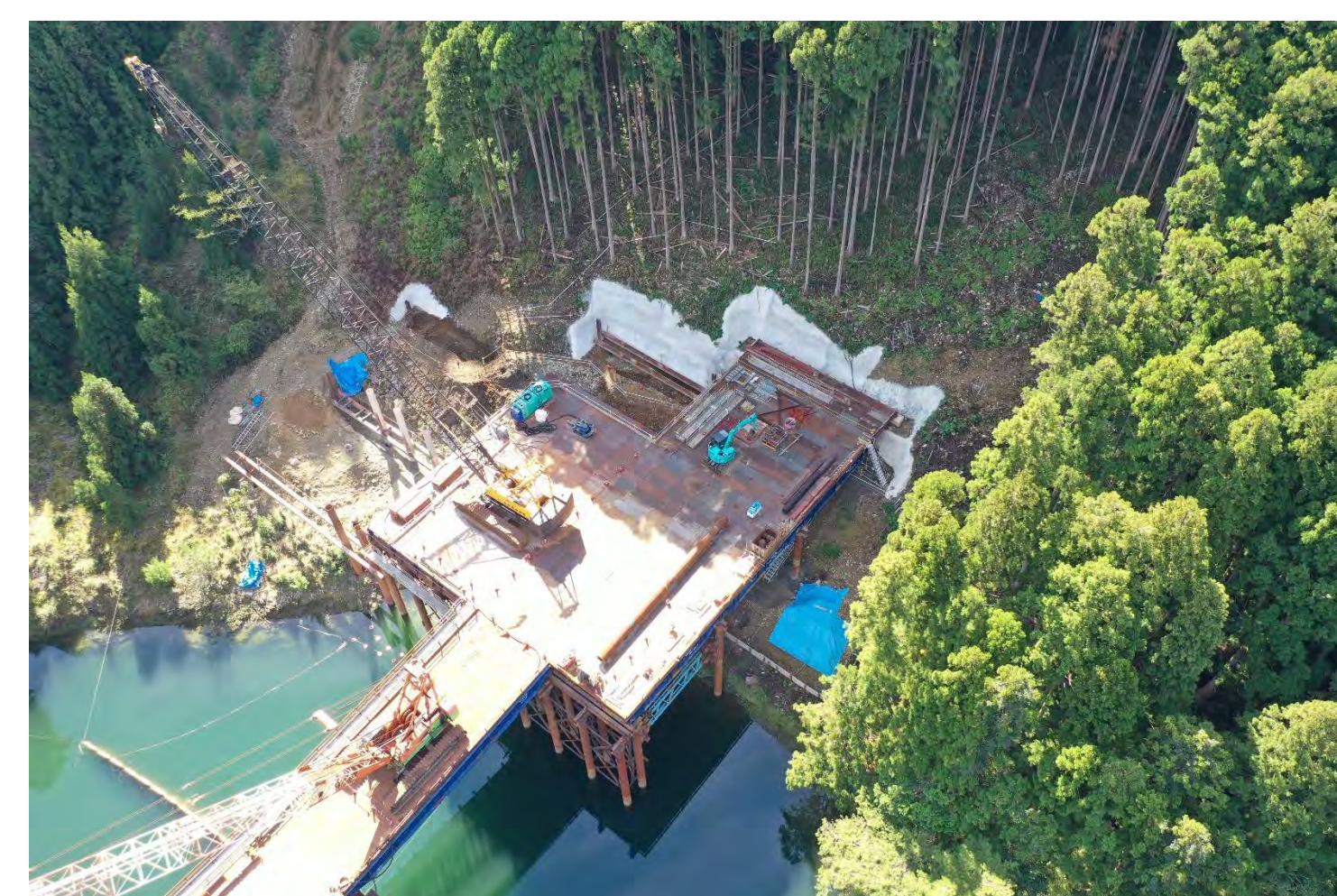
⑤ 1号トンネル他工事
