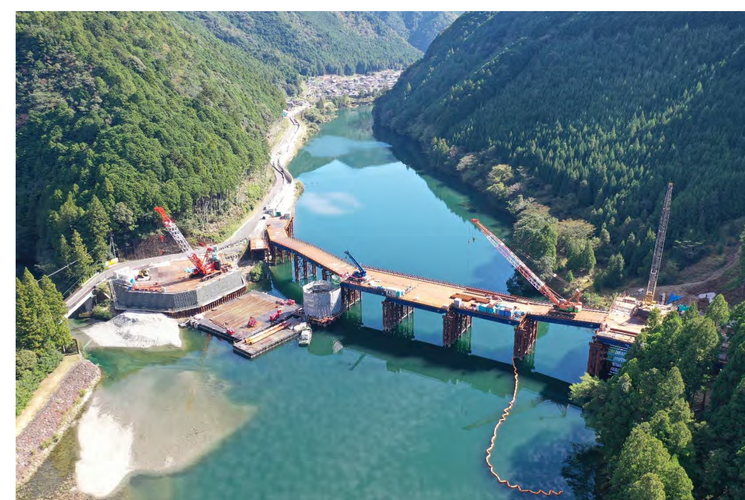
⑥ 1号トンネル他工事
