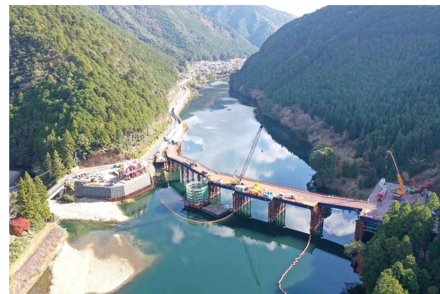
⑥ 1号トンネル他工事
