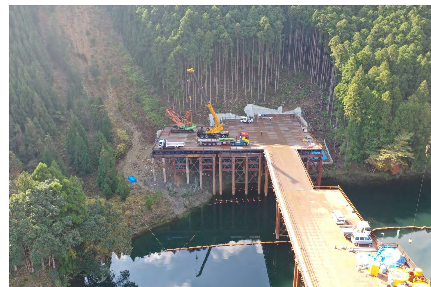
⑤ 1号トンネル他工事
