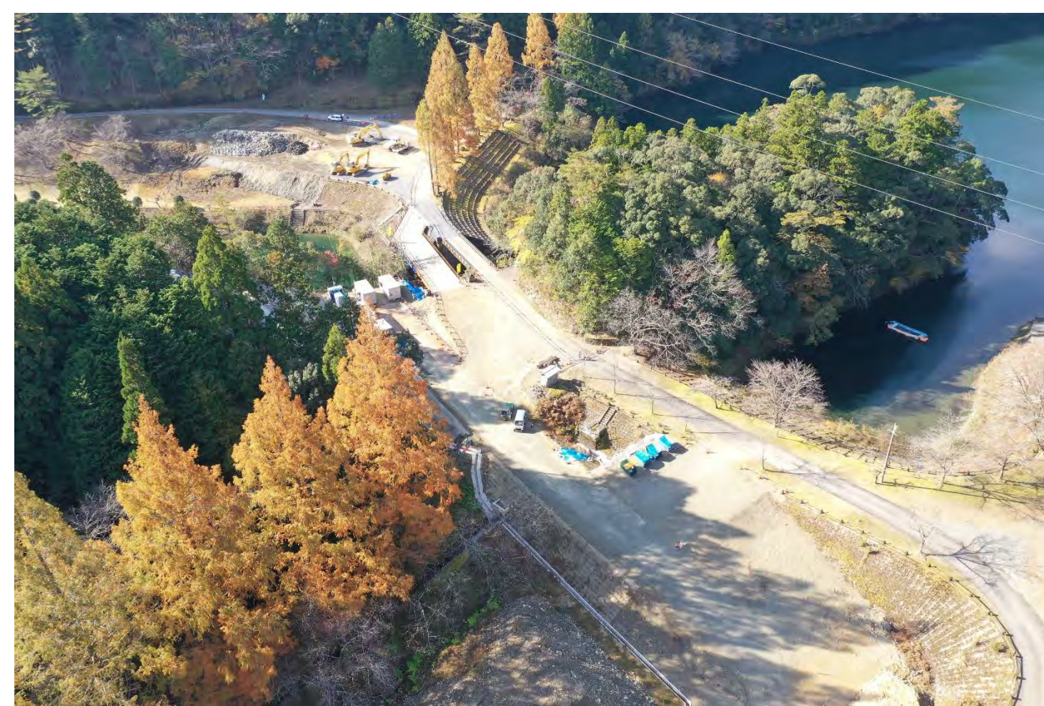
⑦ 2号トンネル他工事
