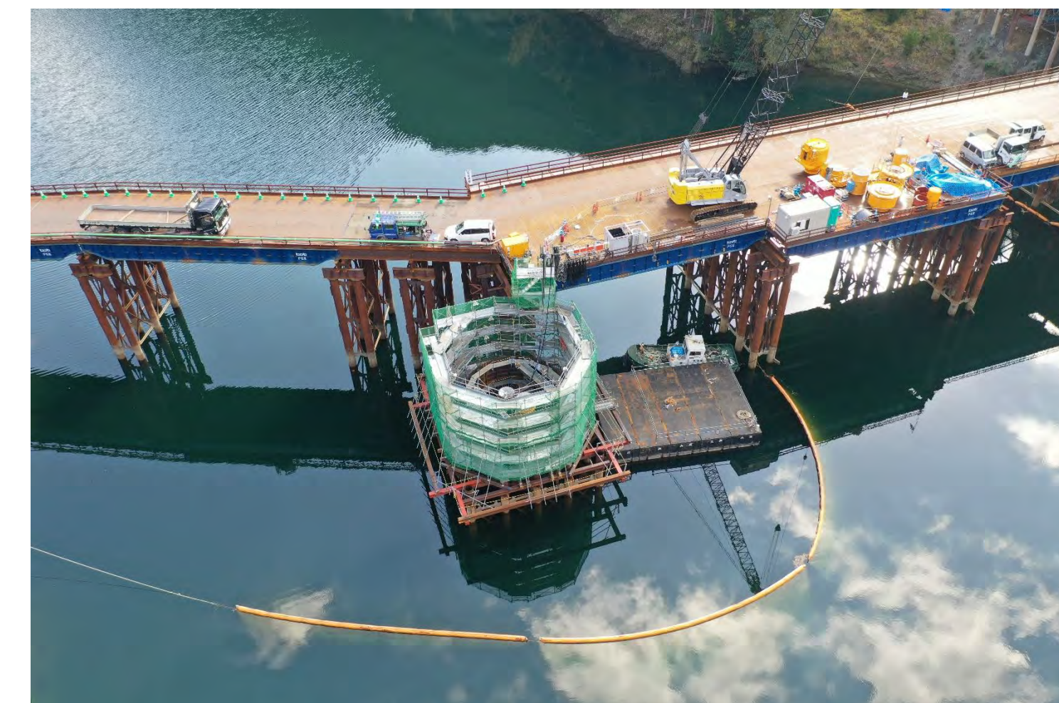
④ 1号橋P1下部工事
