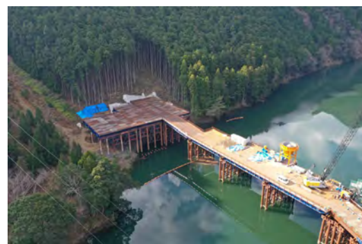
⑤ 1号トンネル他工事
