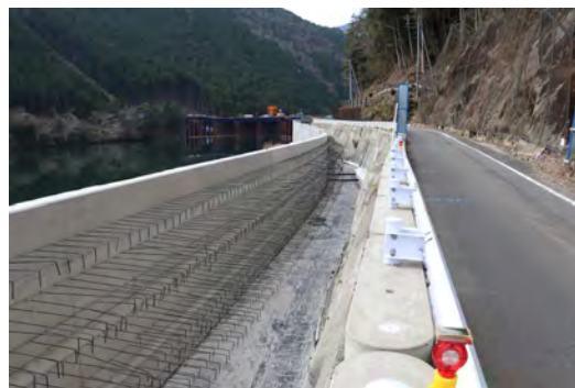
② 下尾井北地区他改良工事(令和3年2月26日完了)
