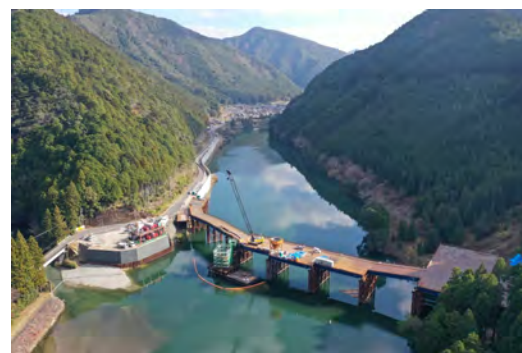
⑥ 1号トンネル他工事
