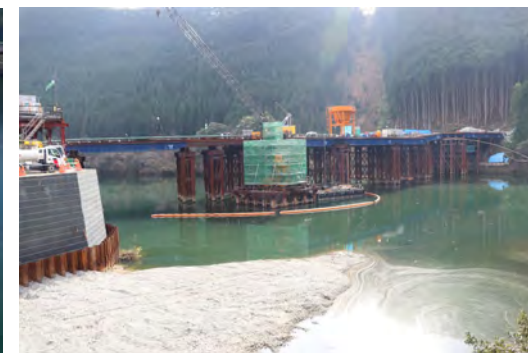
④ 1号橋P1下部工事
