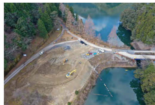
⑦ 2号トンネル他工事
