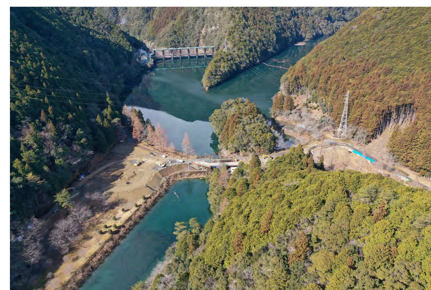
⑦ 2号トンネル他工事
