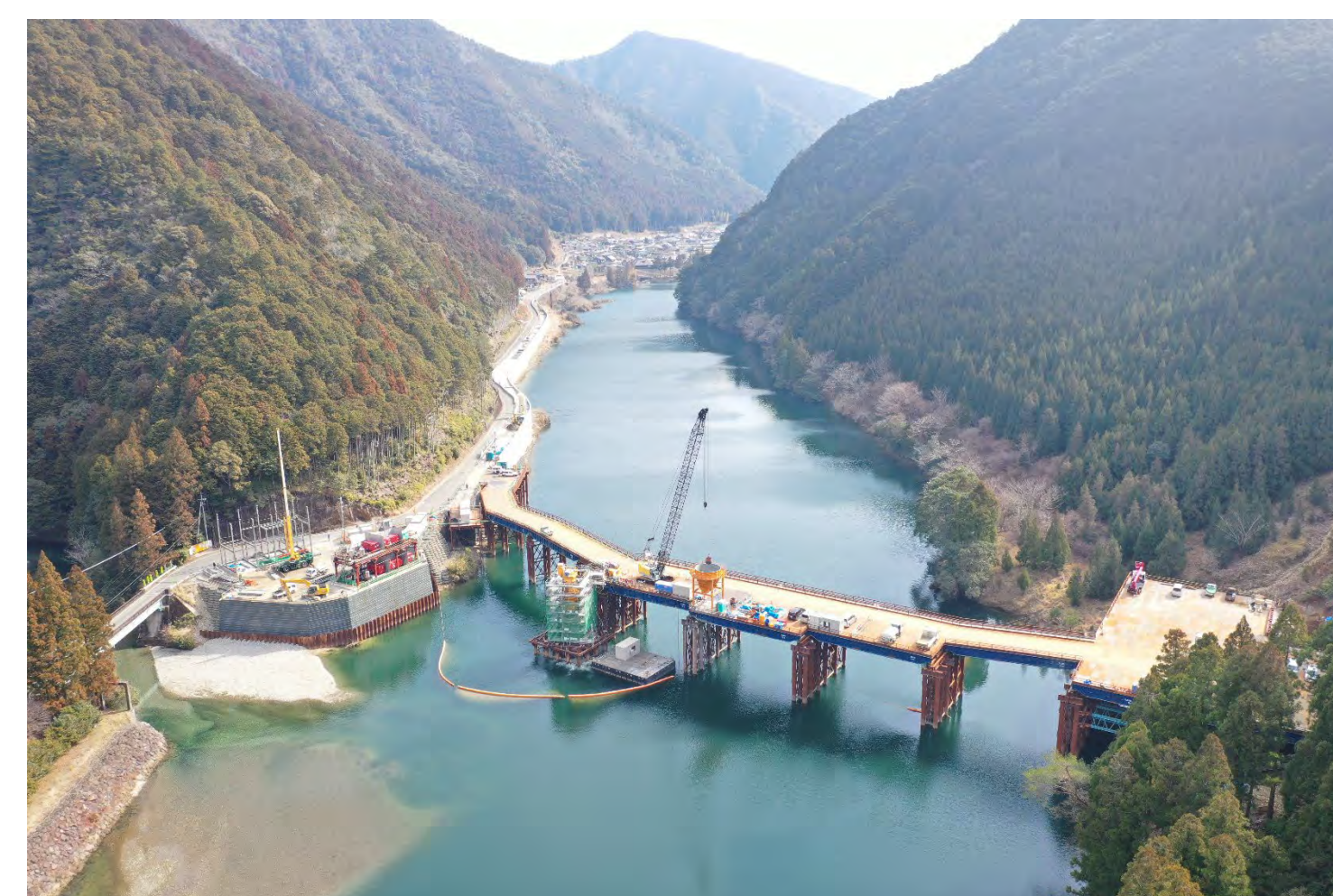
⑥ 1号トンネル他工事
