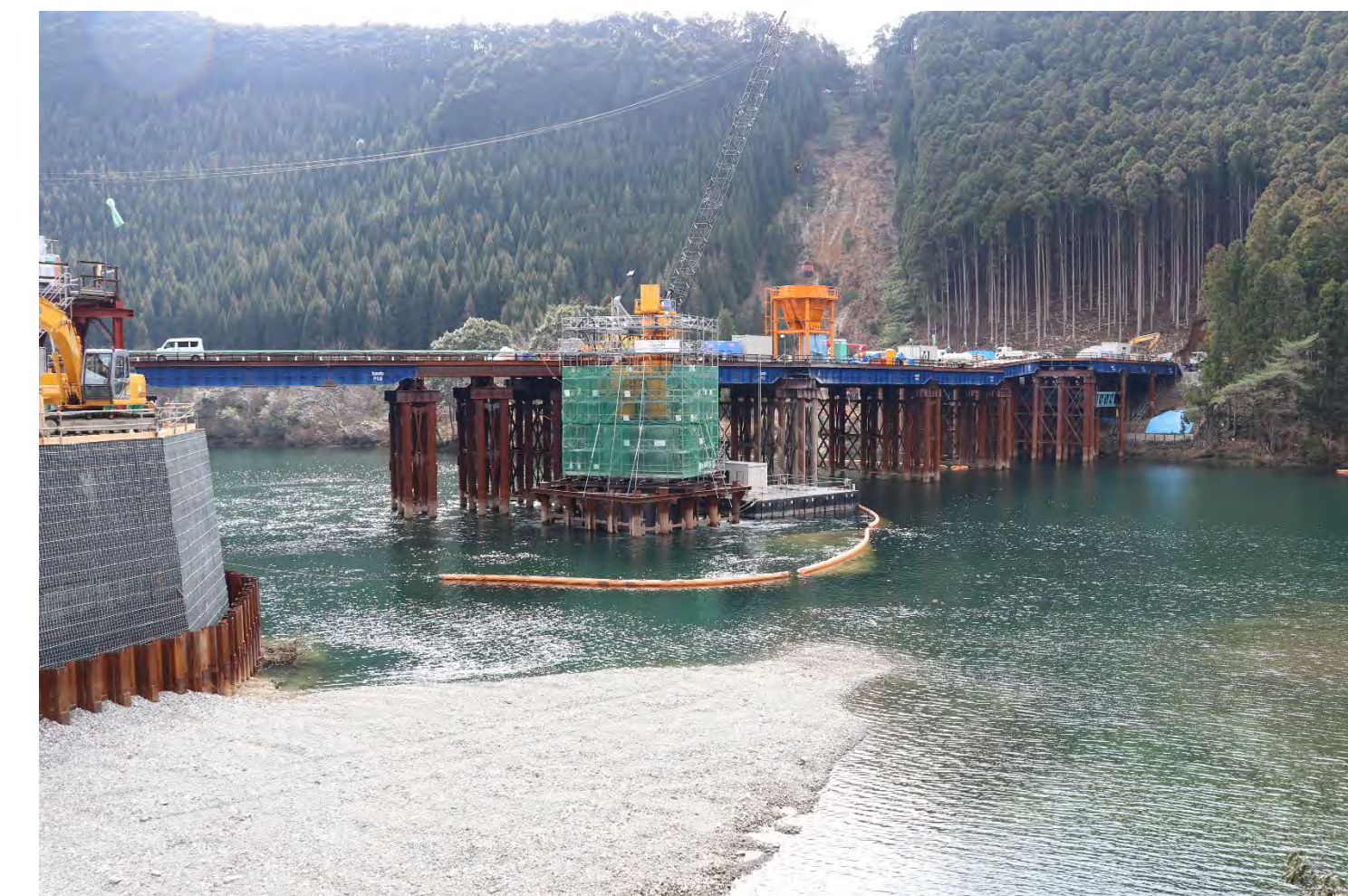
④ 1号橋P1下部工事
