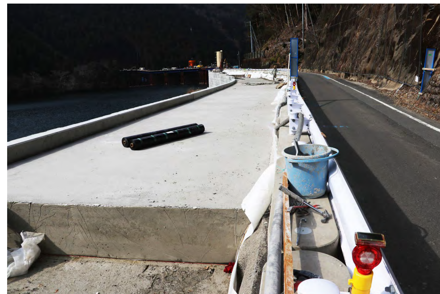
② 下尾井北地区他改良工事
