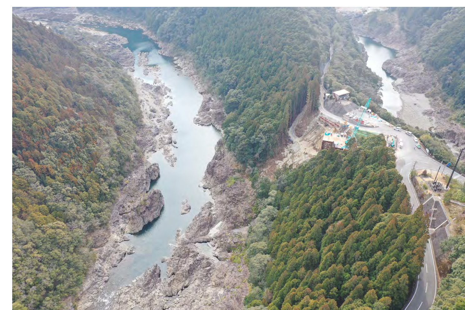
⑧ 3号橋AA2橋脚他工事
