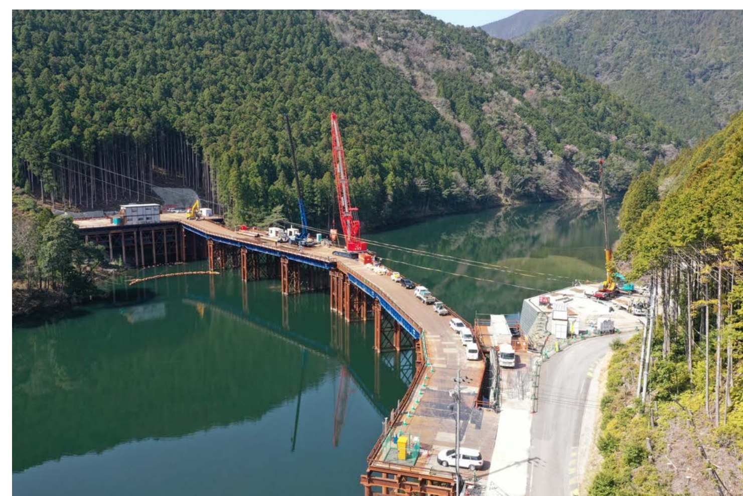
⑤ 北山村下尾井(1号橋・1号トンネル)
