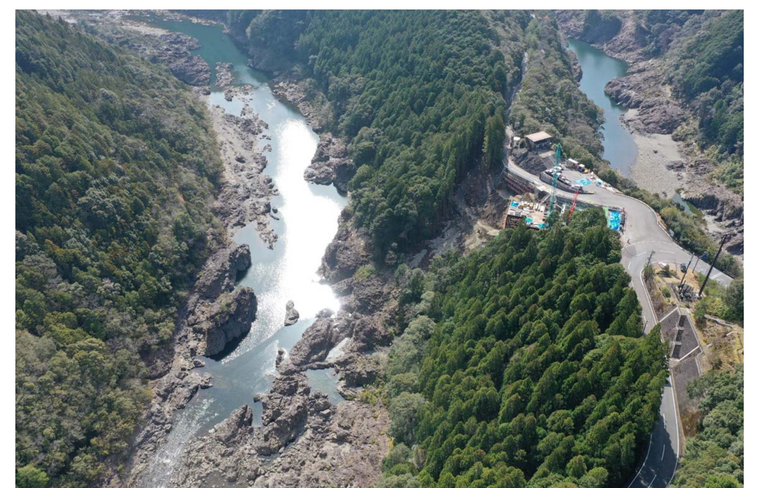
⑧ 北山村小松(3号橋AA2橋脚)
