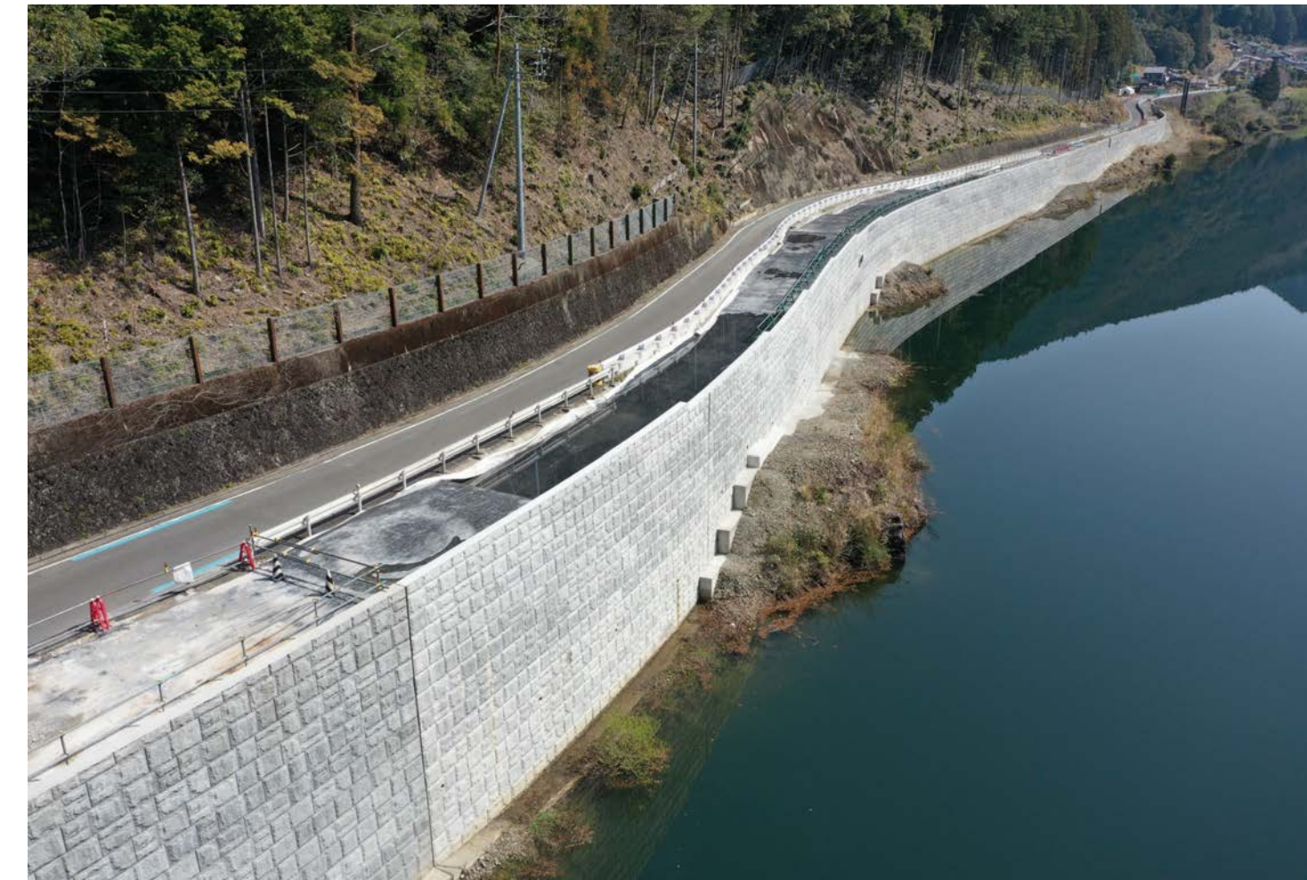
③ 北山村下尾井(道路改良)
