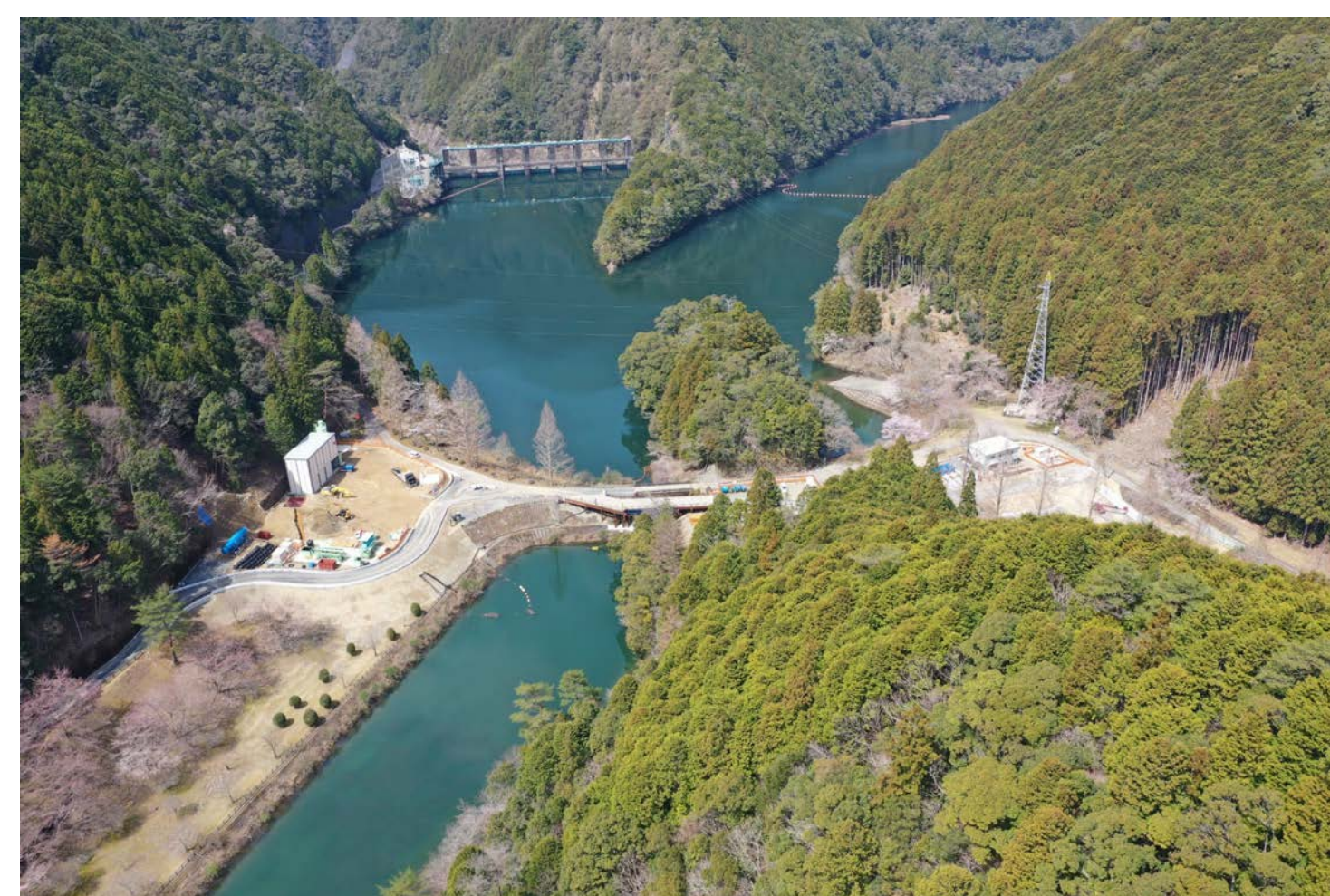
⑦ 熊野市紀和町小森(2号橋・2号トンネル)
