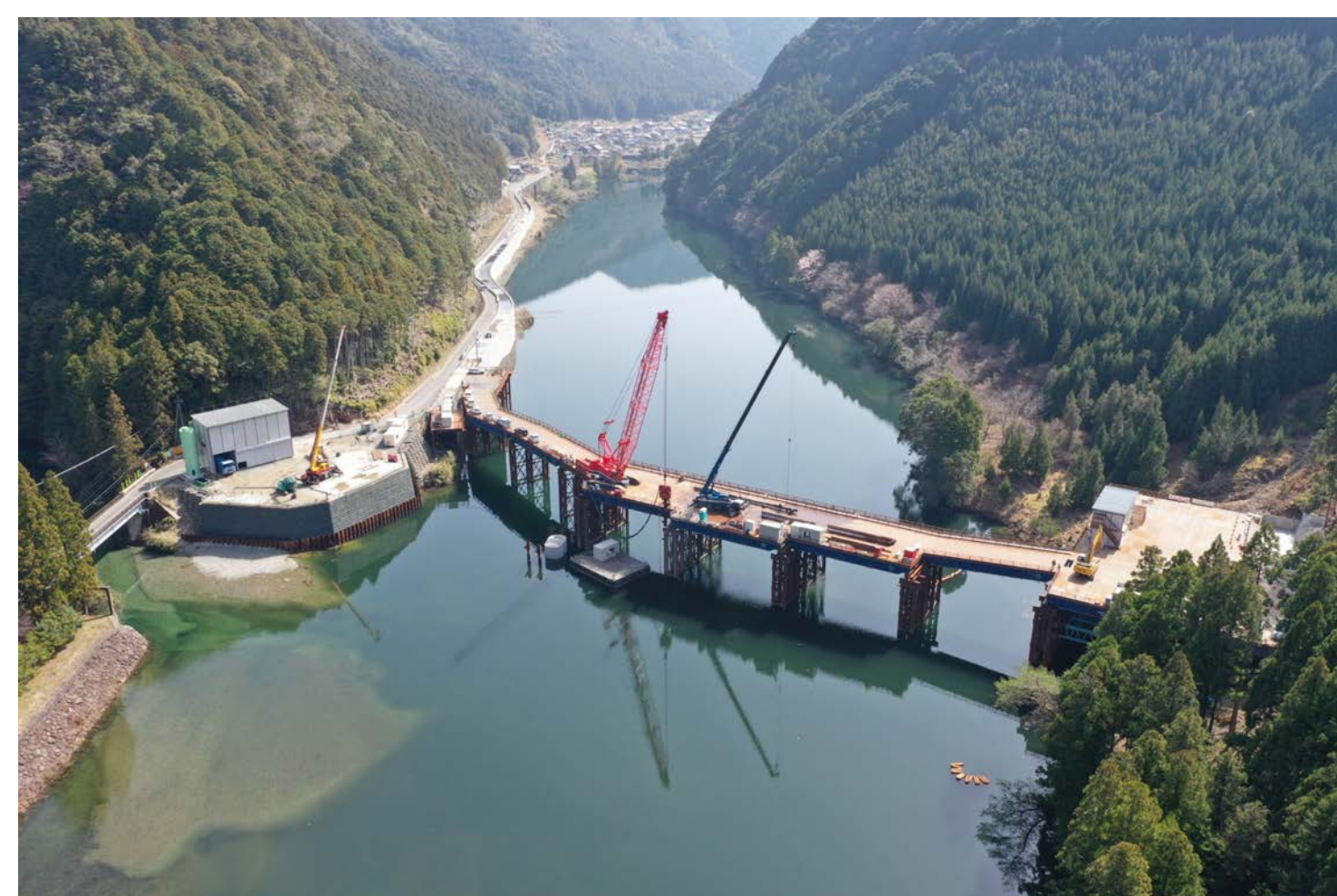
⑥ 北山村下尾井(1号橋・1号トンネル)
