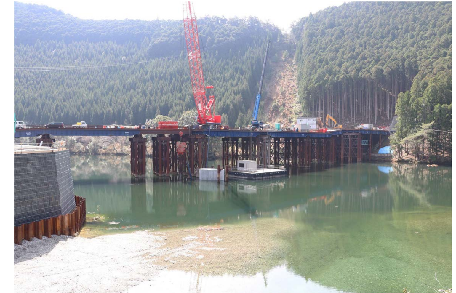
④ 北山村下尾井(1号橋P1橋脚)
