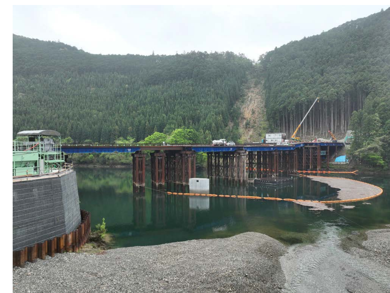
④ 北山村下尾井(1号橋P1橋脚)
