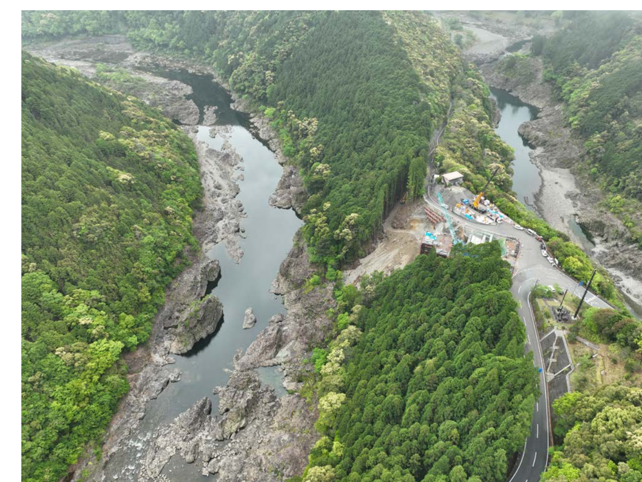
⑧ 北山村小松(3号橋AA2橋脚)
