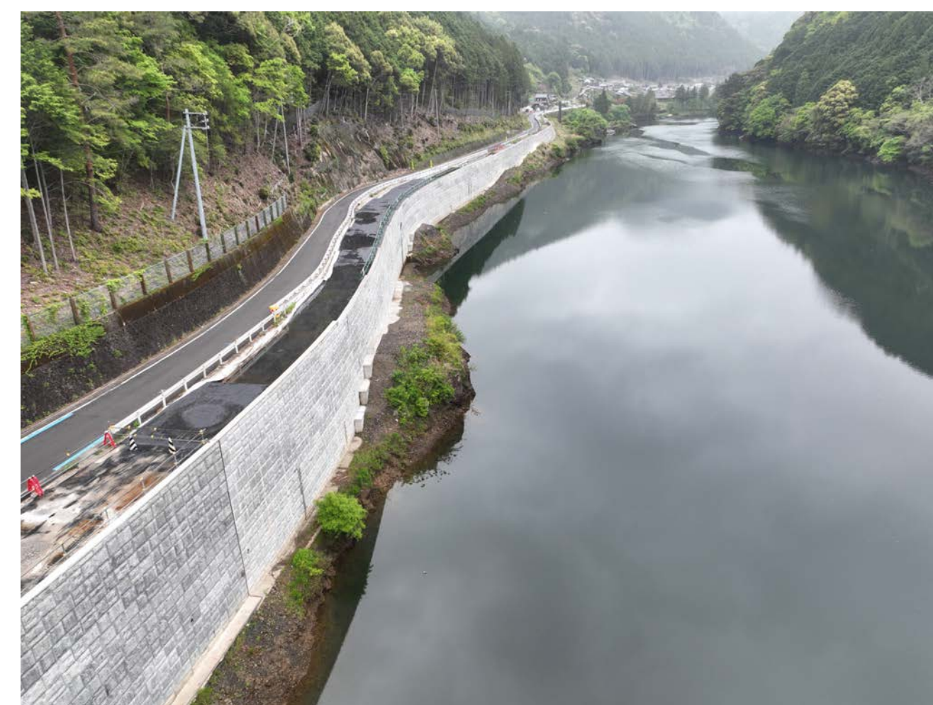
③ 北山村下尾井(道路改良)
