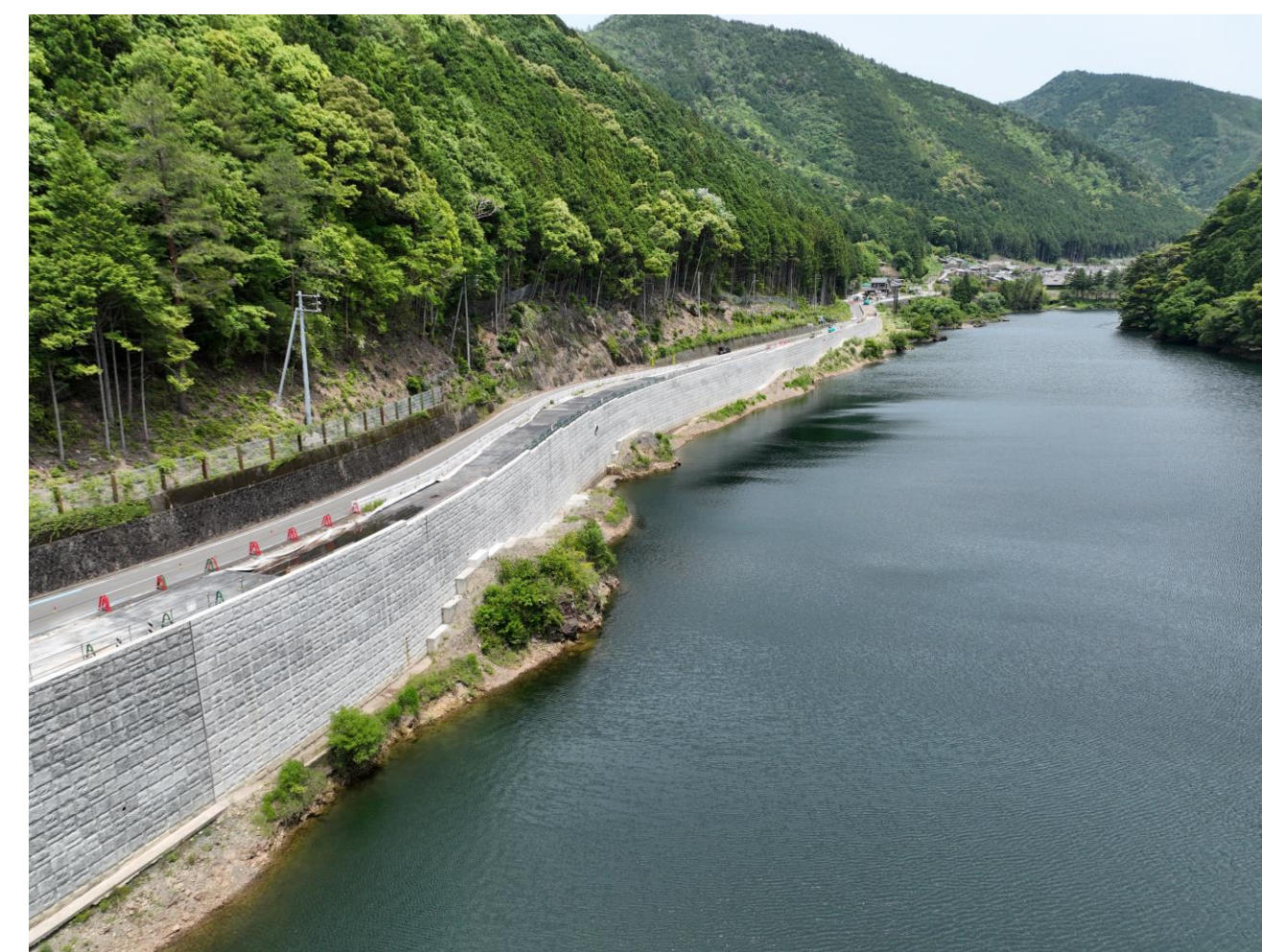
③ 北山村下尾井(道路改良)
