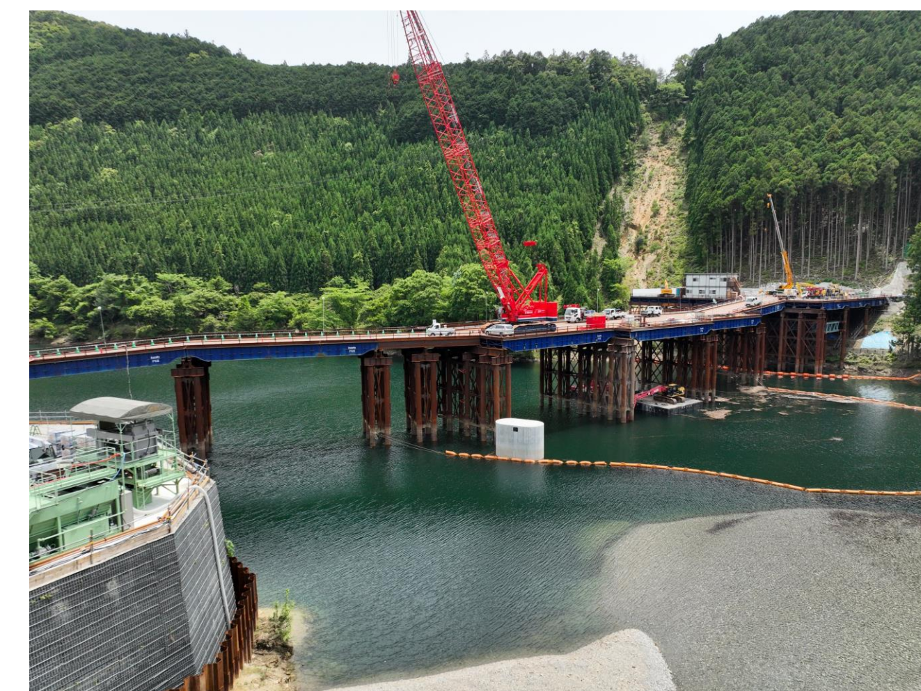
④ 北山村下尾井(1号橋P1橋脚)
