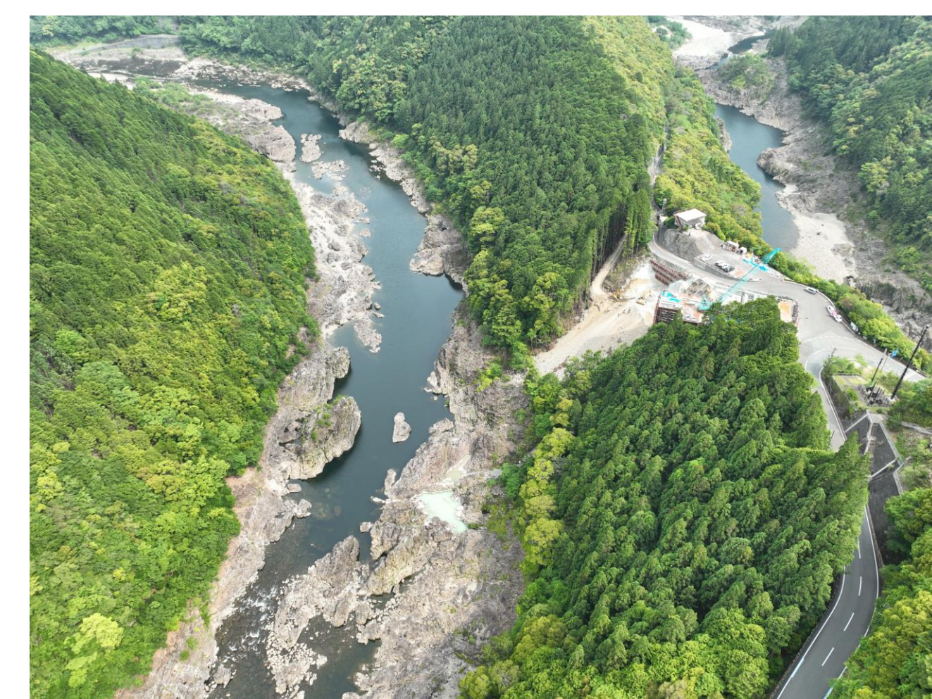
⑧ 北山村小松(3号橋AA2橋脚)
