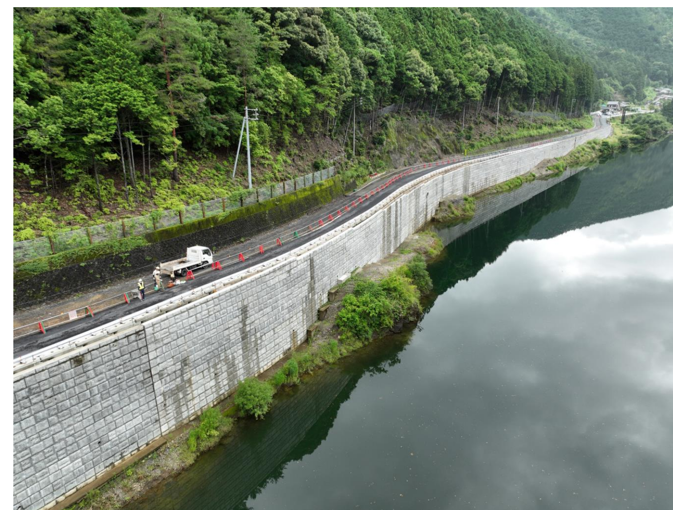
③ 北山村下尾井(道路改良)
