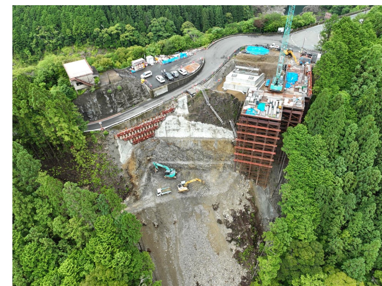
⑧ 北山村小松(3号橋AA2橋脚)
