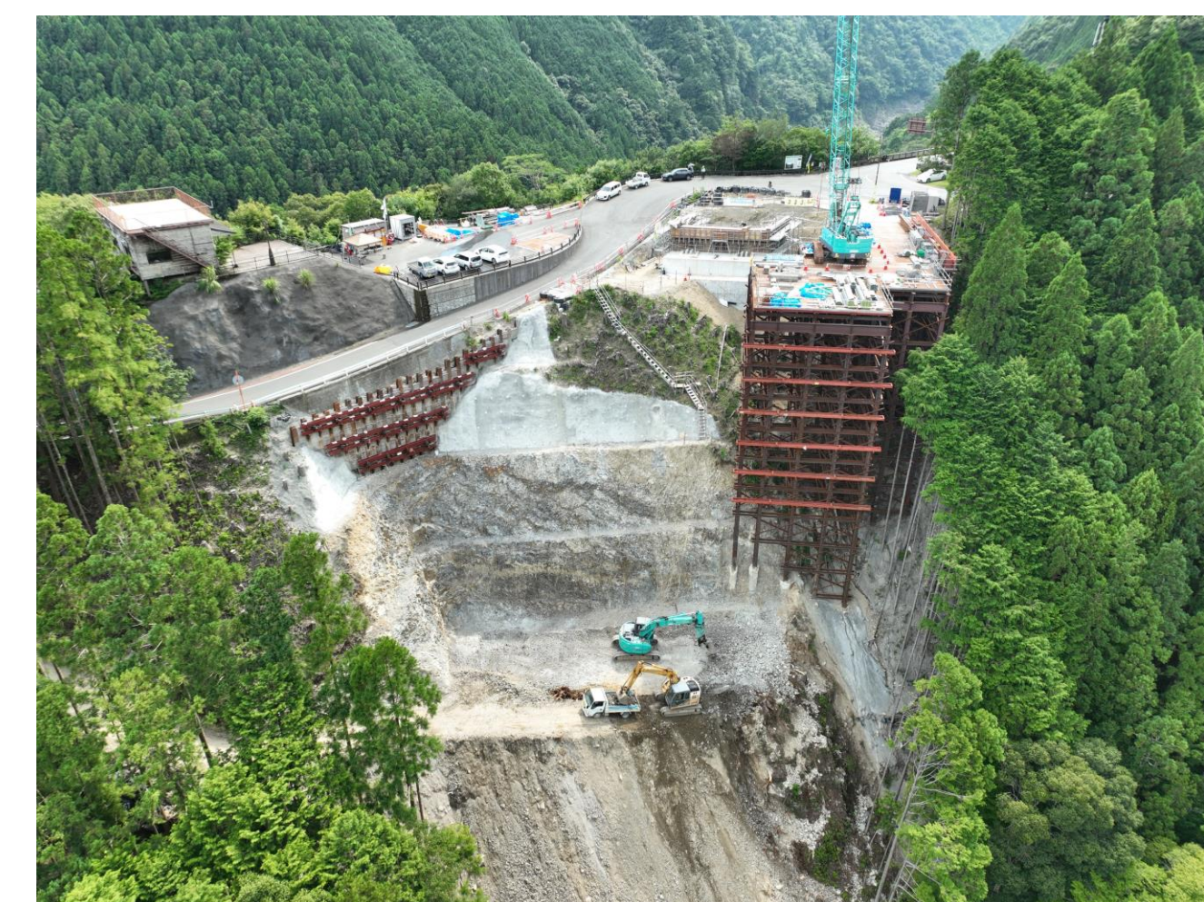
⑧ 北山村小松(3号橋AA2橋脚)
