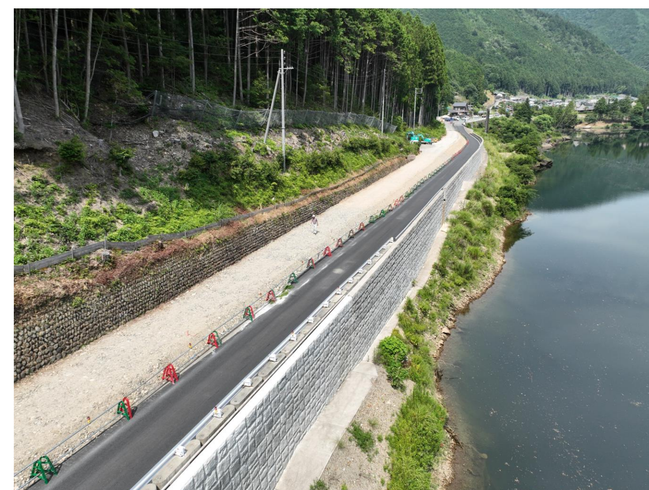
③ 北山村下尾井(道路改良)
