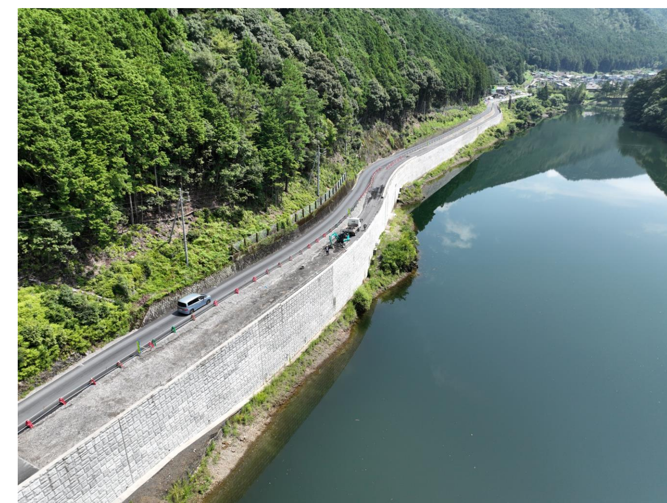
③ 北山村下尾井(道路改良)
