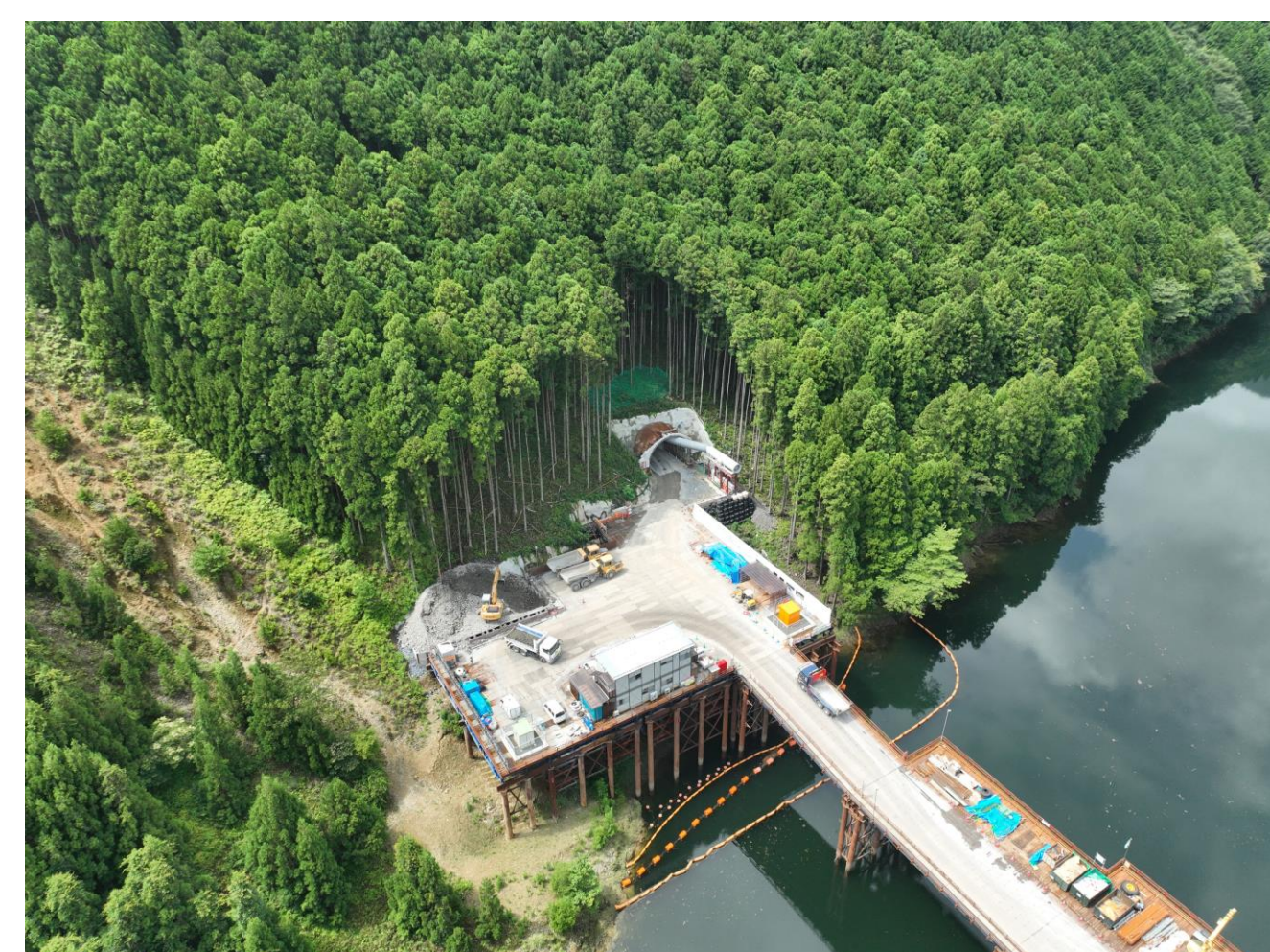
⑤ 北山村下尾井(1号橋・1号トンネル)
