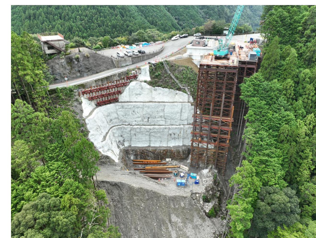
⑧ 北山村小松(3号橋AA2橋脚)
