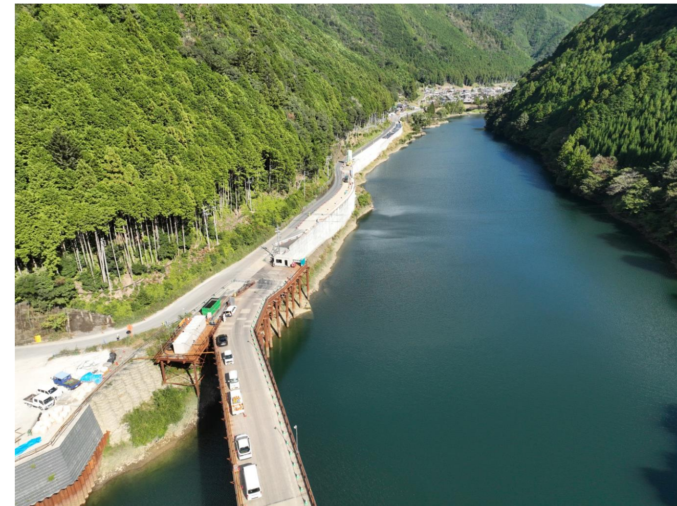
③ 北山村下尾井(道路改良)
