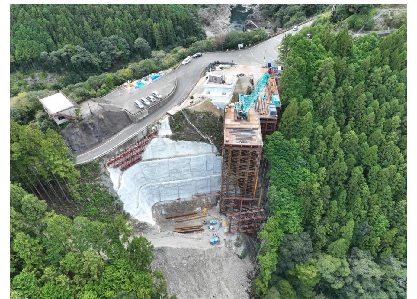
⑧ 北山村小松(3号橋AA2橋脚)
