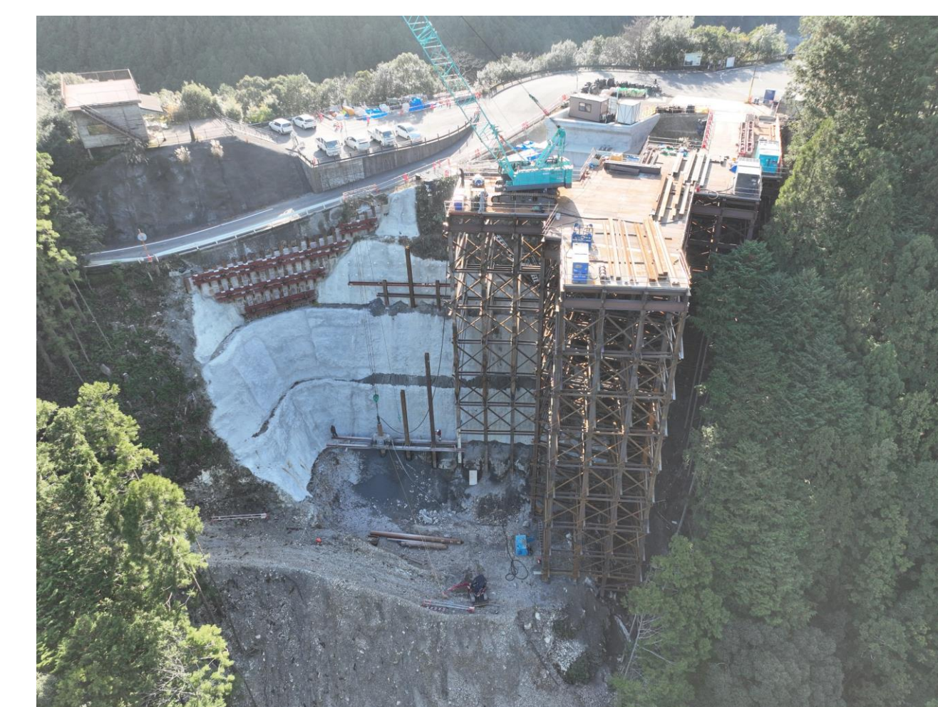
⑧ 北山村小松(3号橋AA2橋脚)
