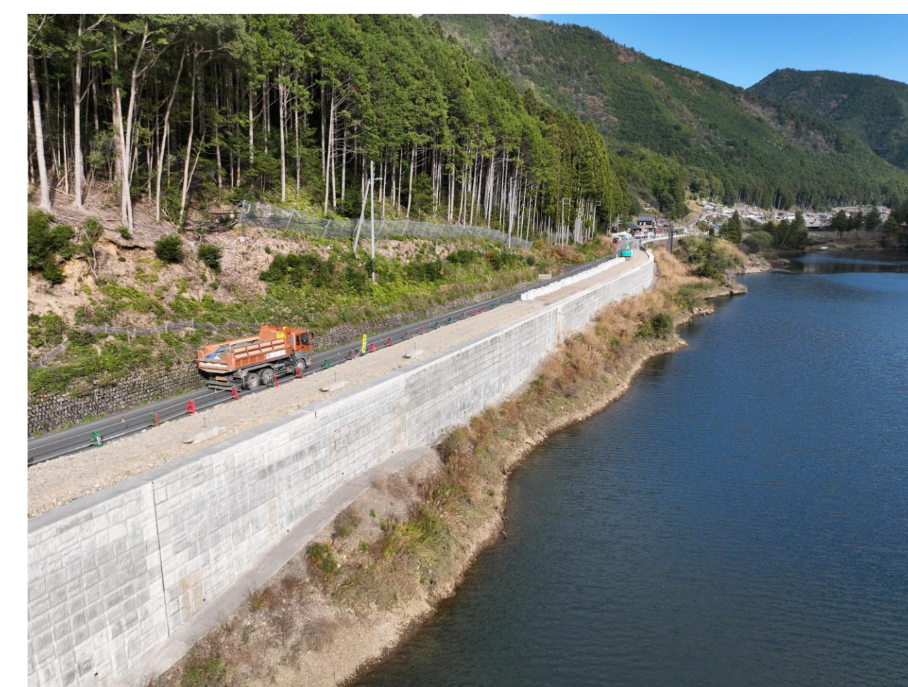
③ 北山村下尾井(道路改良)
