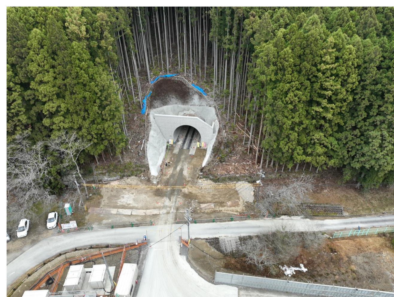
⑥ 熊野市紀和町小森(1号トンネル)
