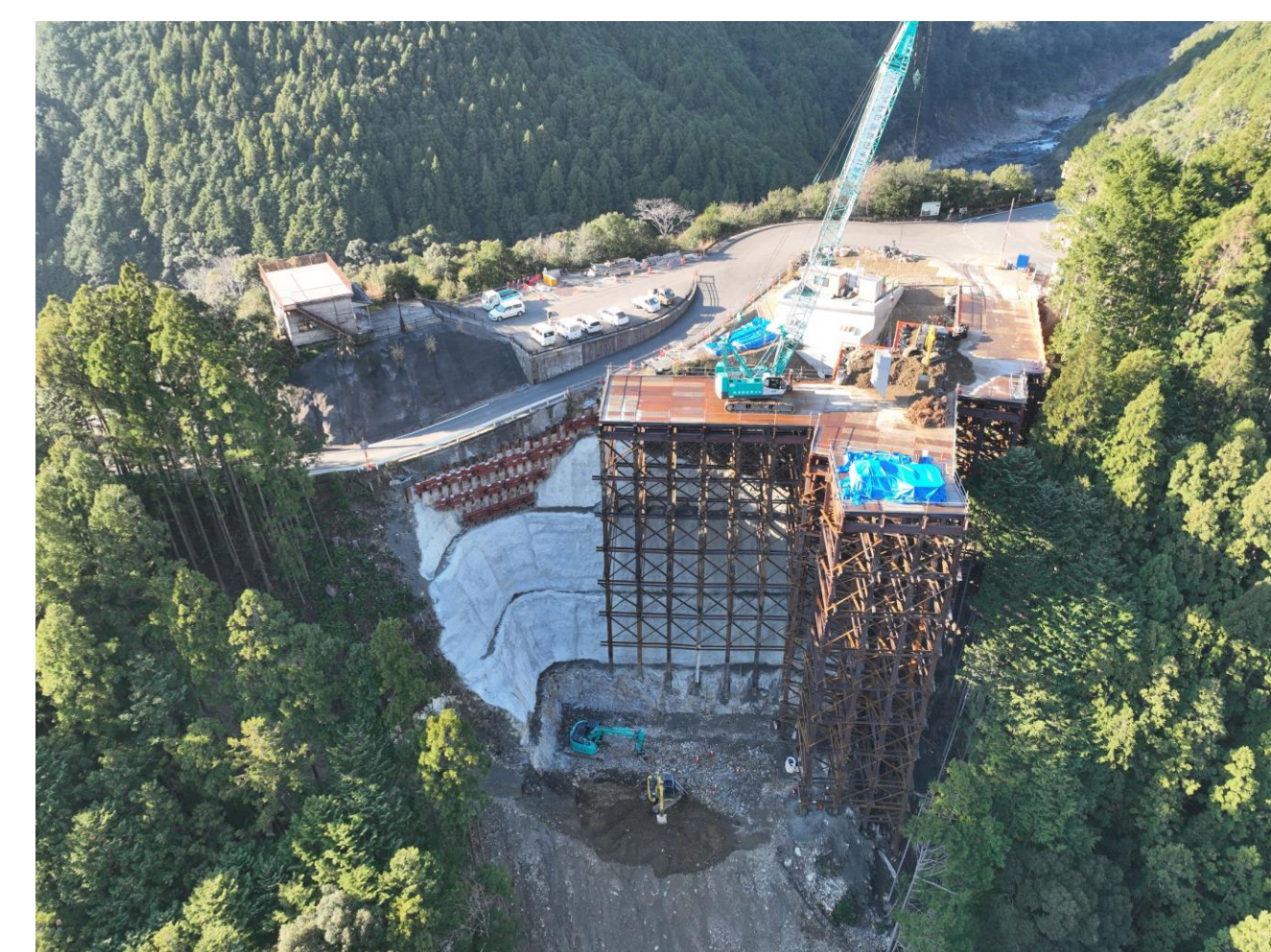
⑧ 北山村小松(3号橋AA2橋脚)
