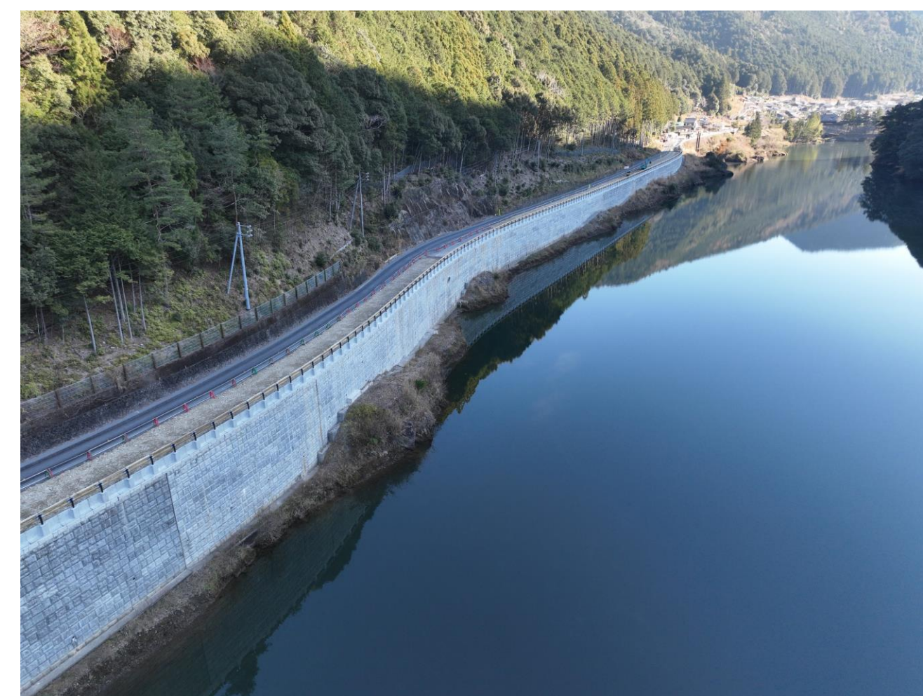
③ 北山村下尾井(道路改良)
