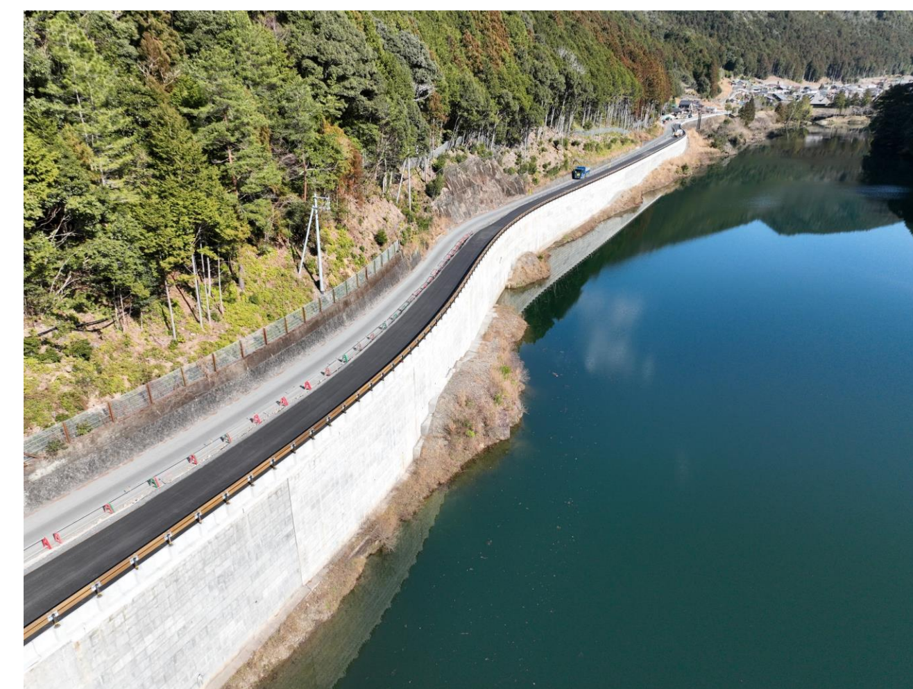
③ 北山村下尾井(道路改良)
