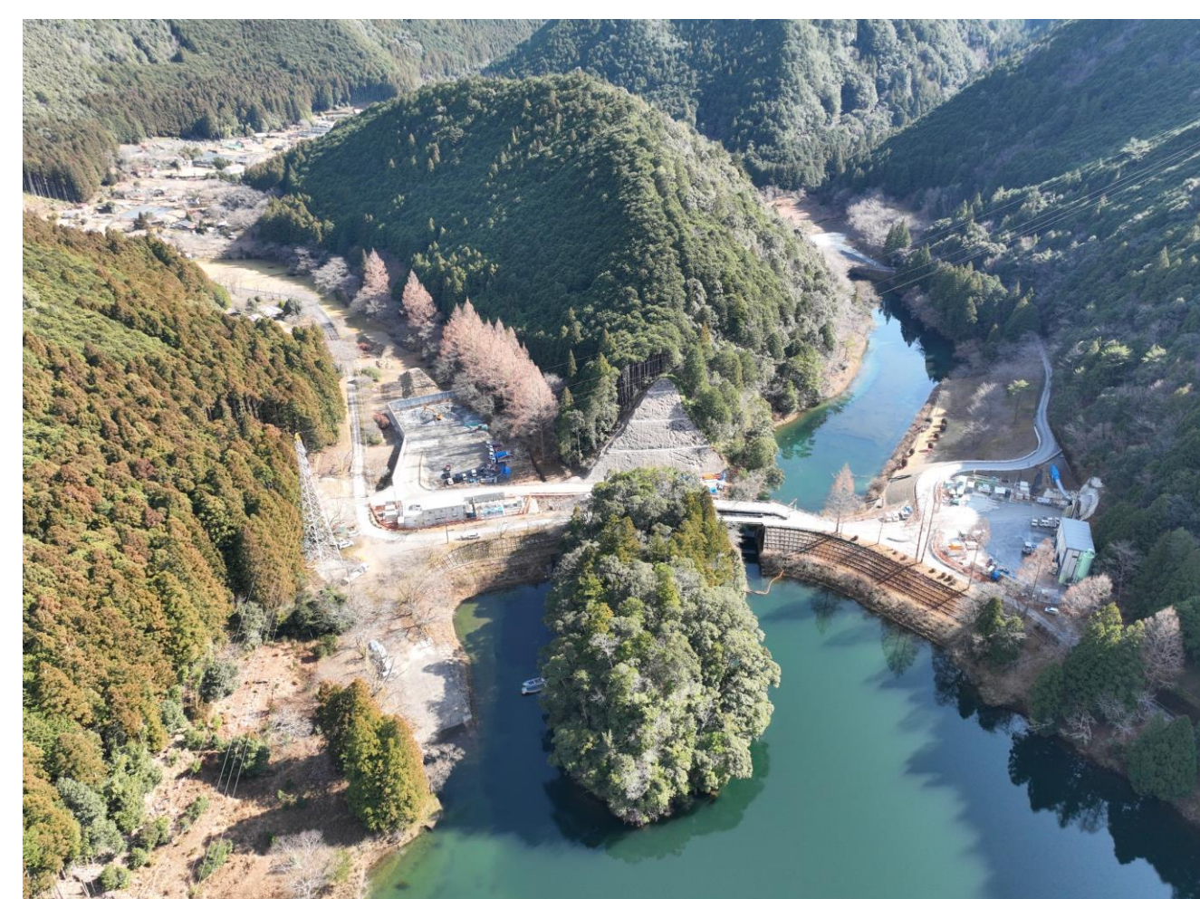
⑤ 熊野市紀和町小森(2号橋・2号トンネル)
