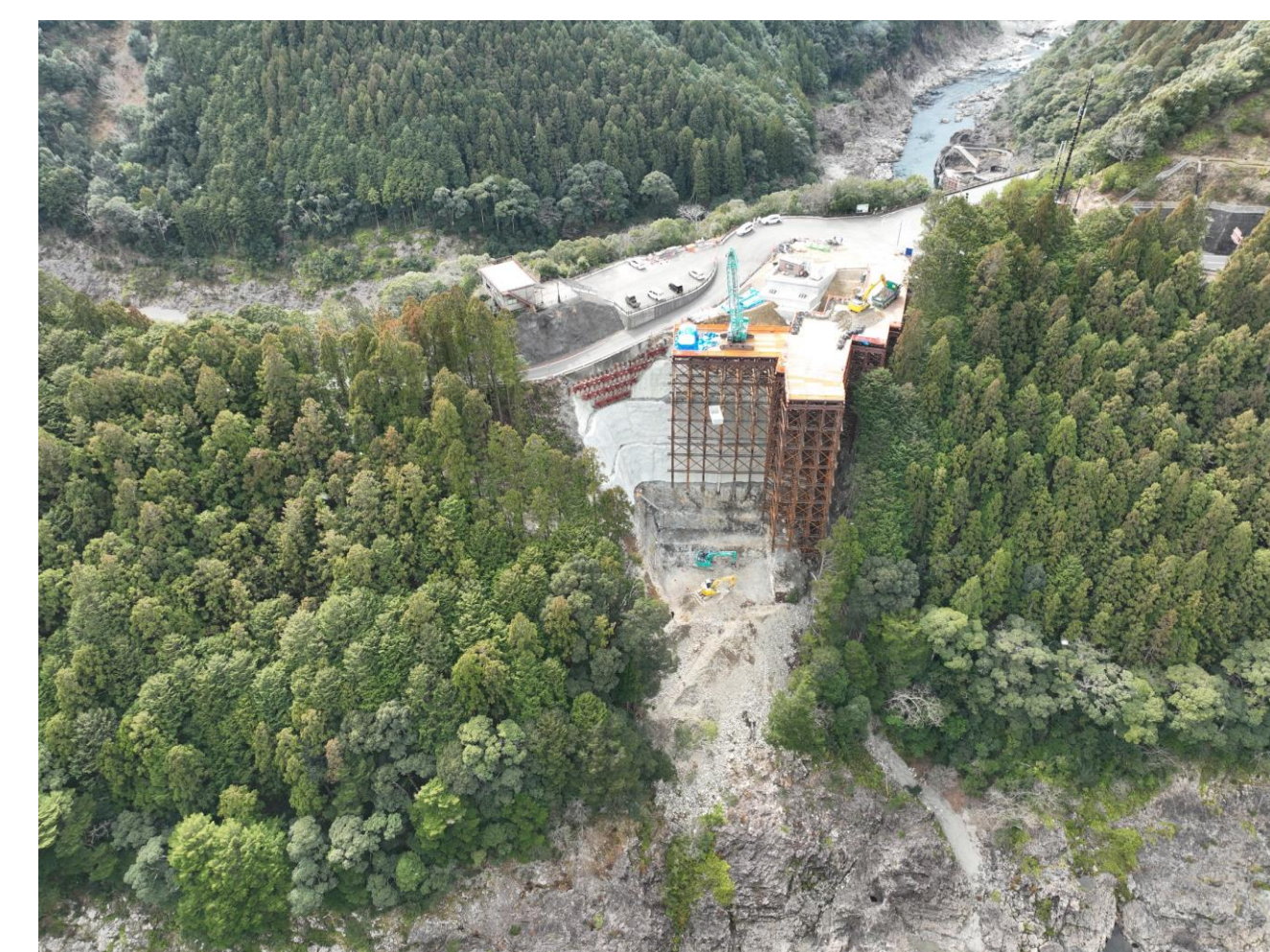
⑧ 北山村小松(3号橋AA2橋脚)
