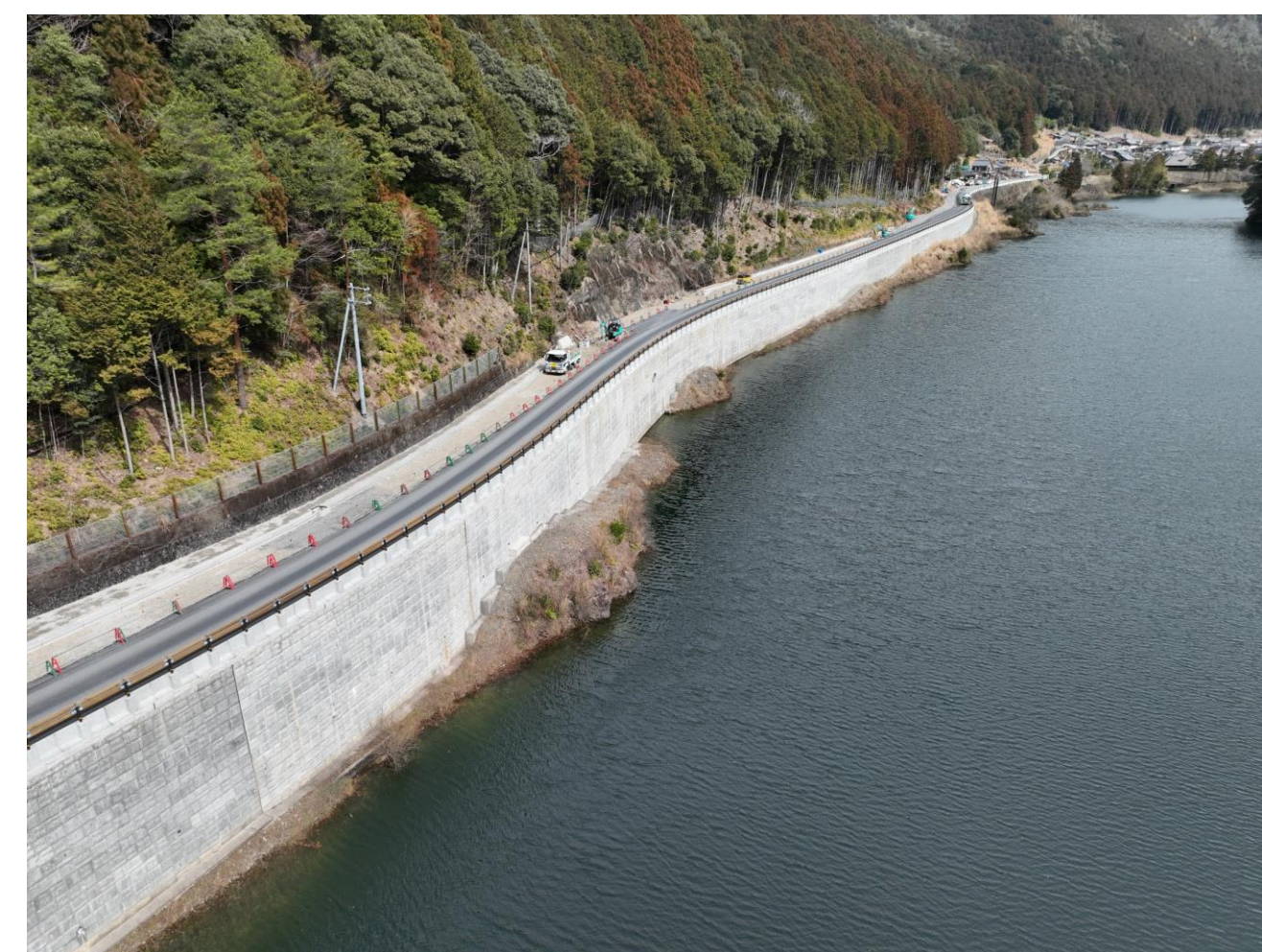
③ 北山村下尾井(道路改良)
