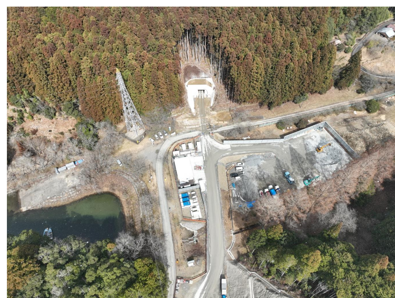
⑥ 熊野市紀和町小森(1号トンネル)
