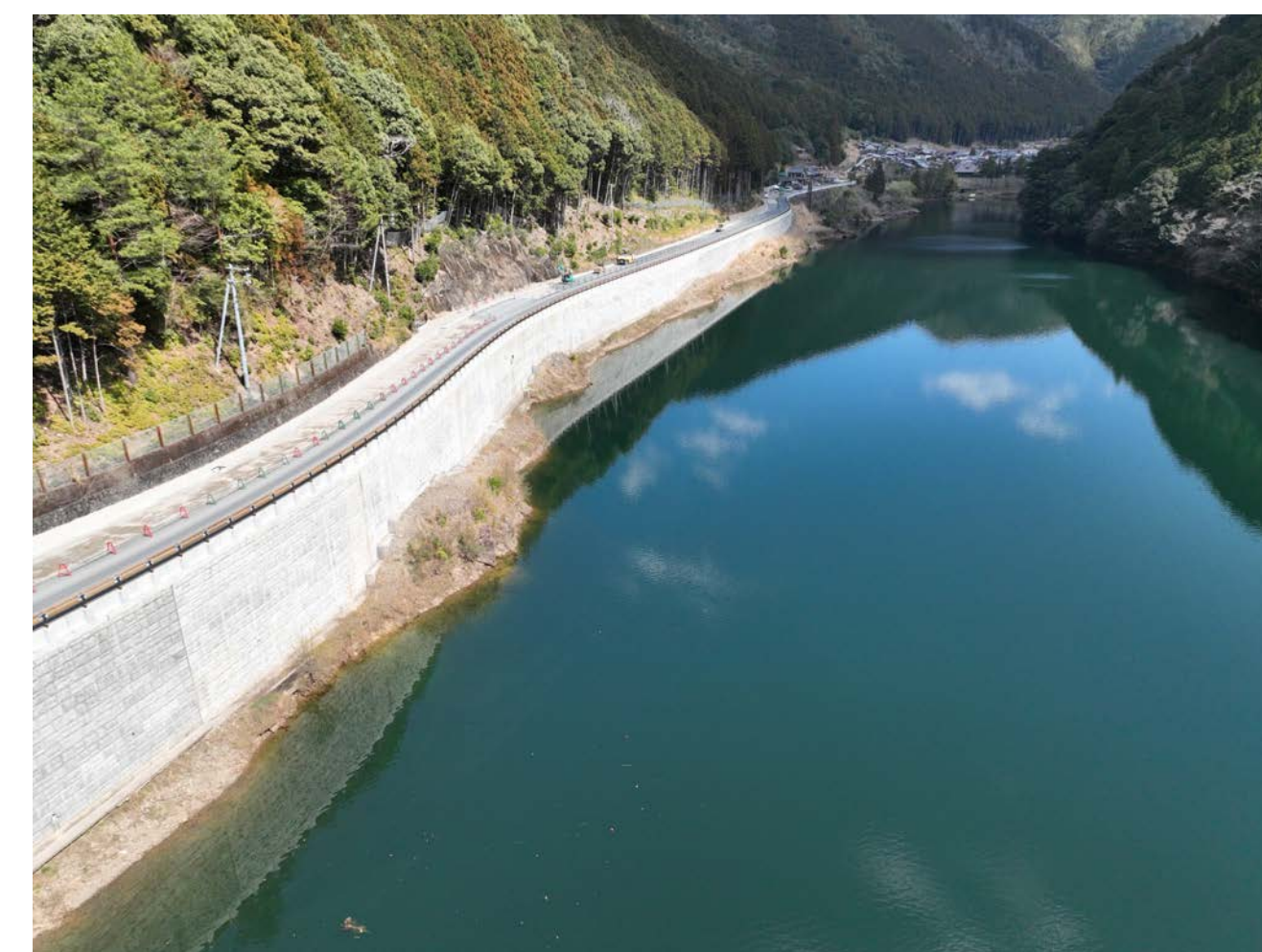
③ 北山村下尾井(道路改良)
