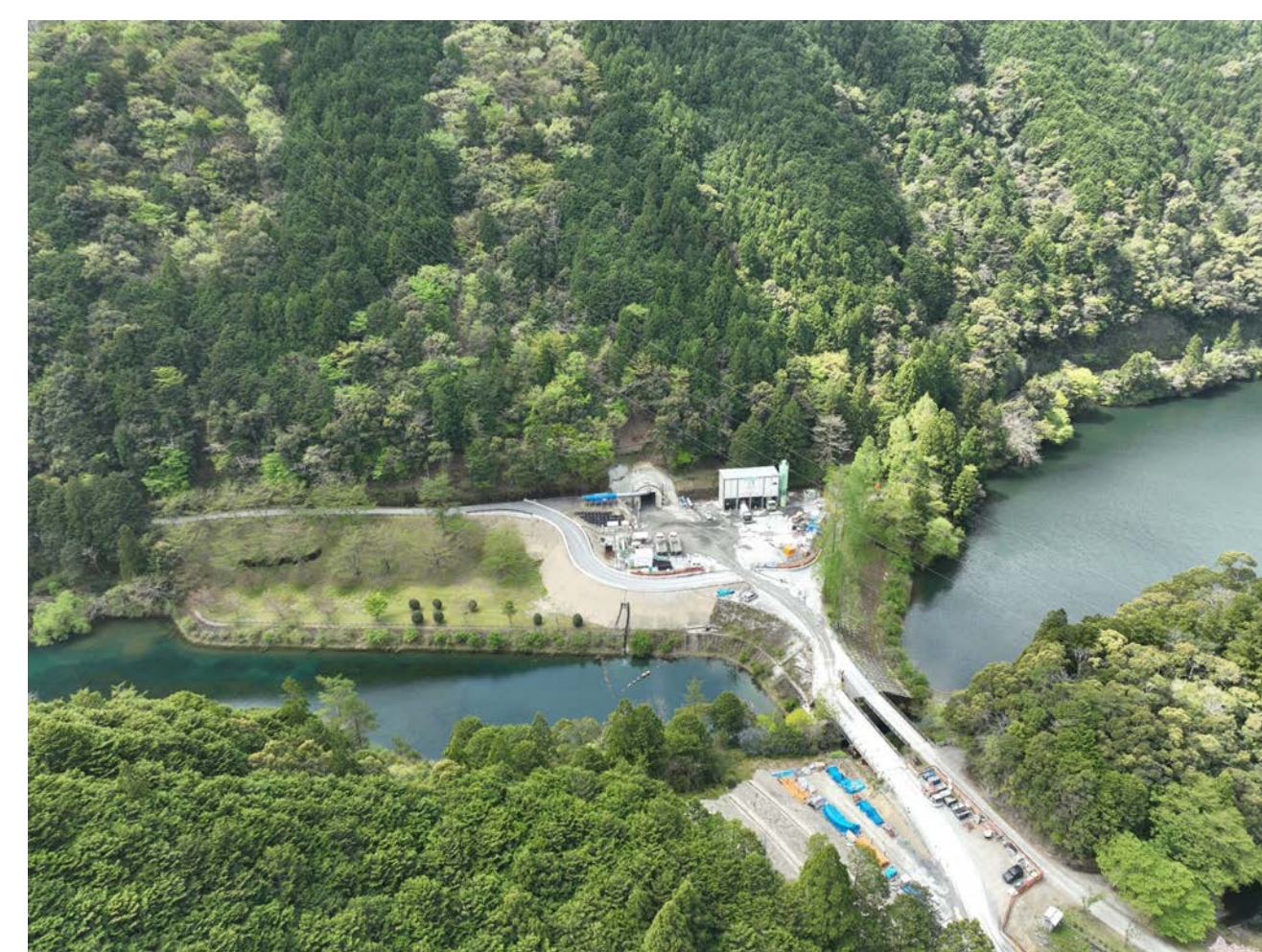
⑦ 熊野市紀和町小森(2号橋・2号トンネル)
