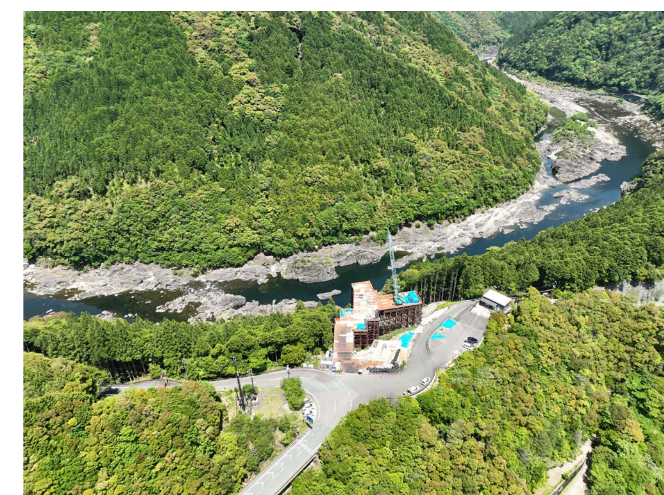
⑧ 北山村小松(3号橋AA2橋脚)
