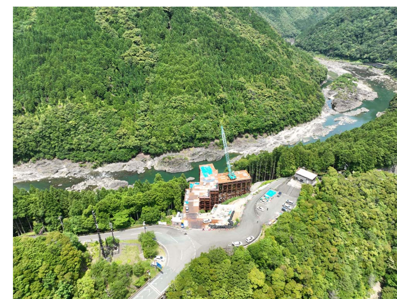
⑧ 北山村小松(3号橋AA2橋脚)
