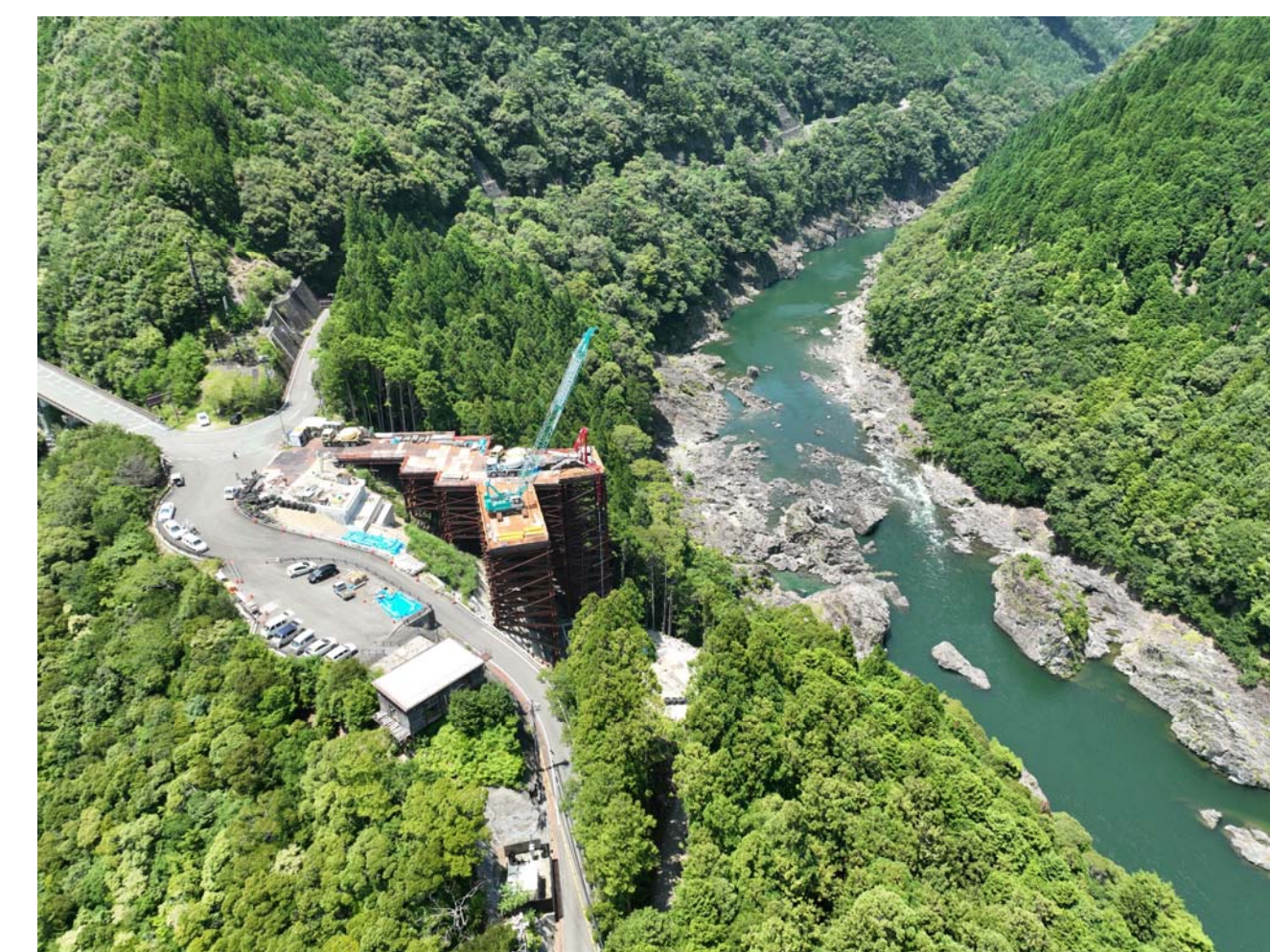
⑧ 北山村小松(3号橋AA2橋脚)
