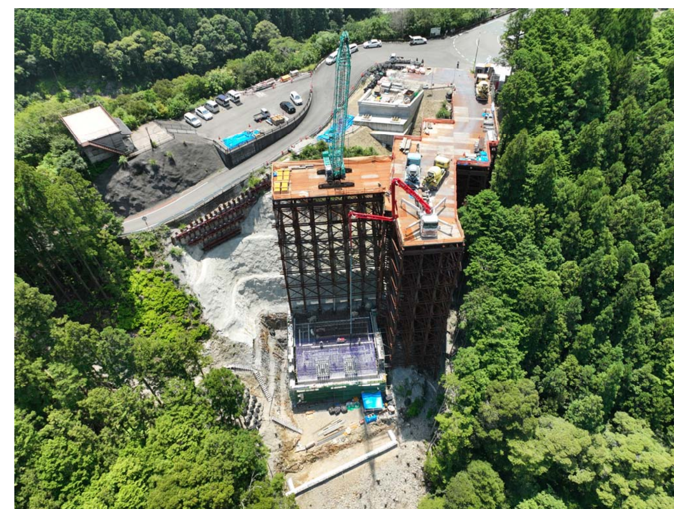
⑦ 北山村小松(3号橋AA2橋脚)
