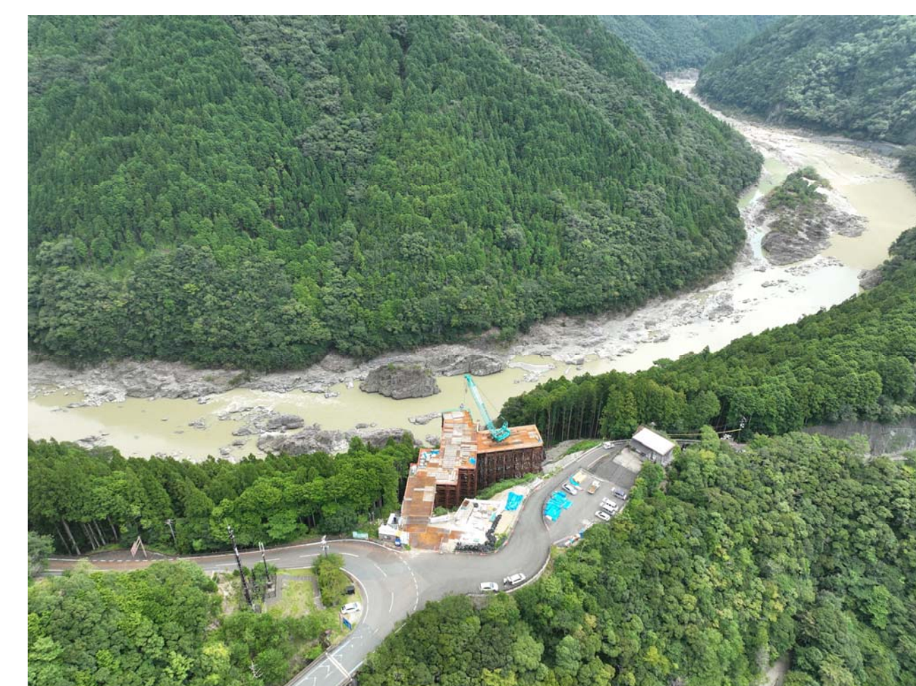
⑧ 北山村小松(3号橋AA2橋脚)
