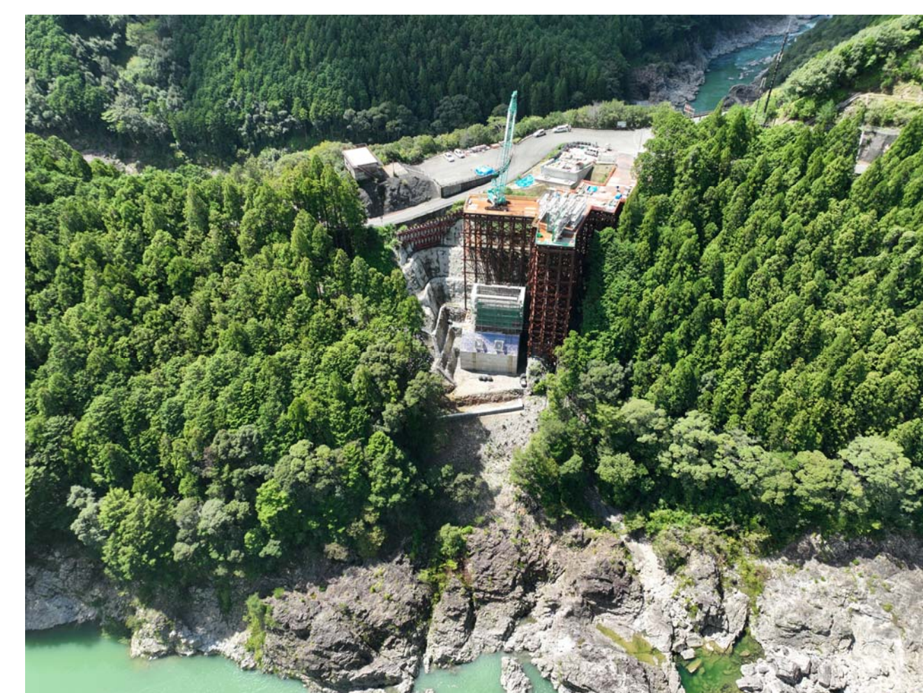
⑦ 北山村小松(3号橋AA2橋脚)
