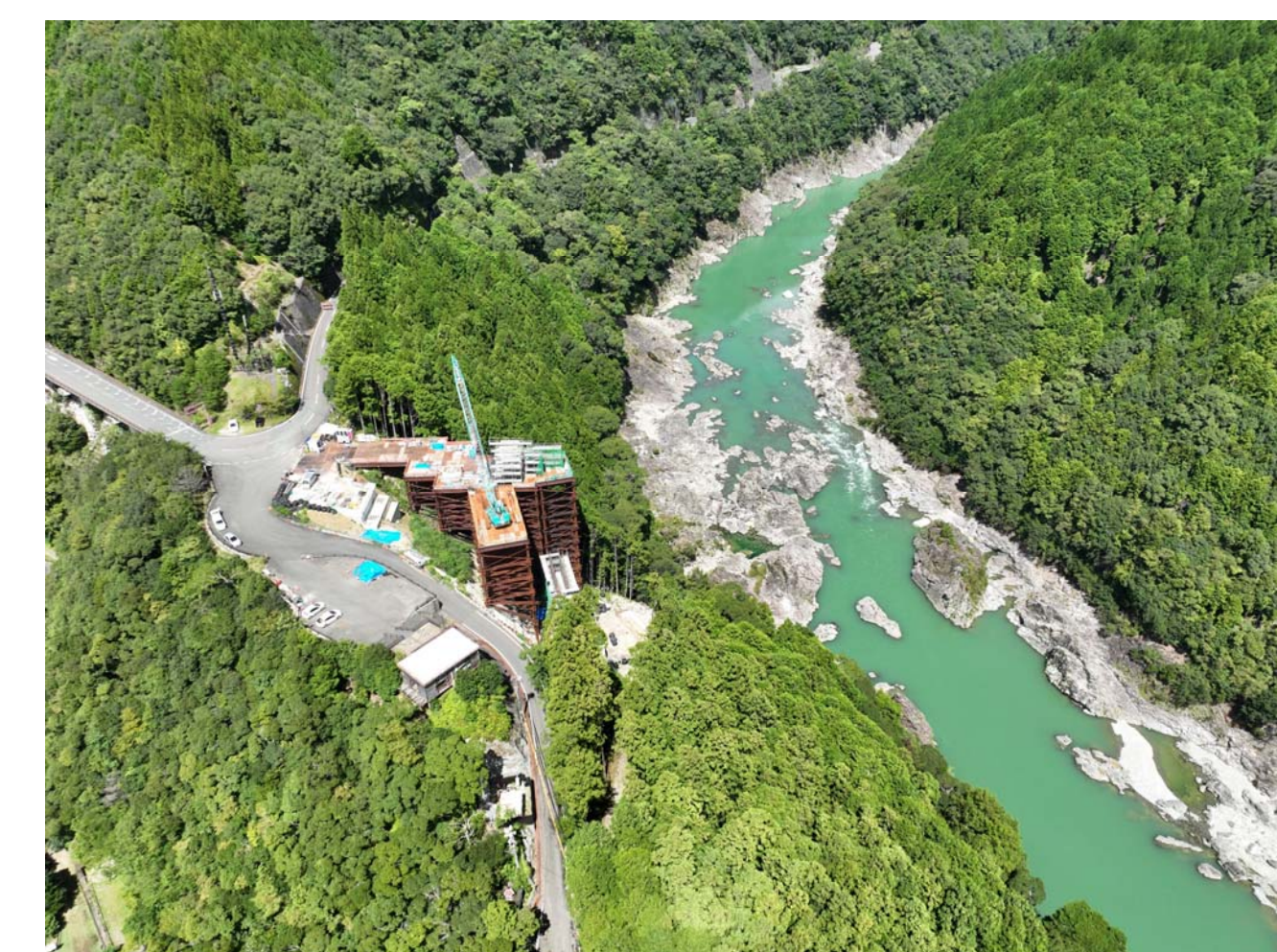
⑧ 北山村小松(3号橋AA2橋脚)
