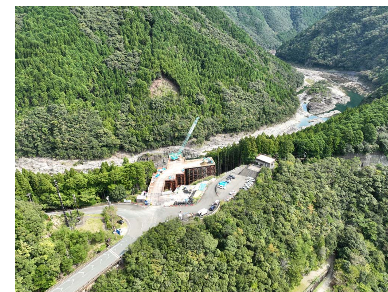
⑧ 北山村小松(3号橋AA2橋脚)
