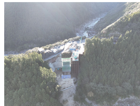
⑦ 北山村小松 (3号橋AA2橋脚)
