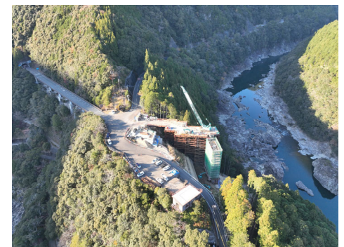
⑧ 北山村小松 (3号橋AA2橋脚)
