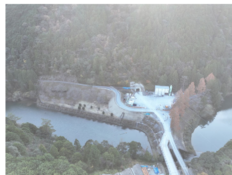
⑥ 熊野市紀和町小森 (2号橋・2号トンネル)
