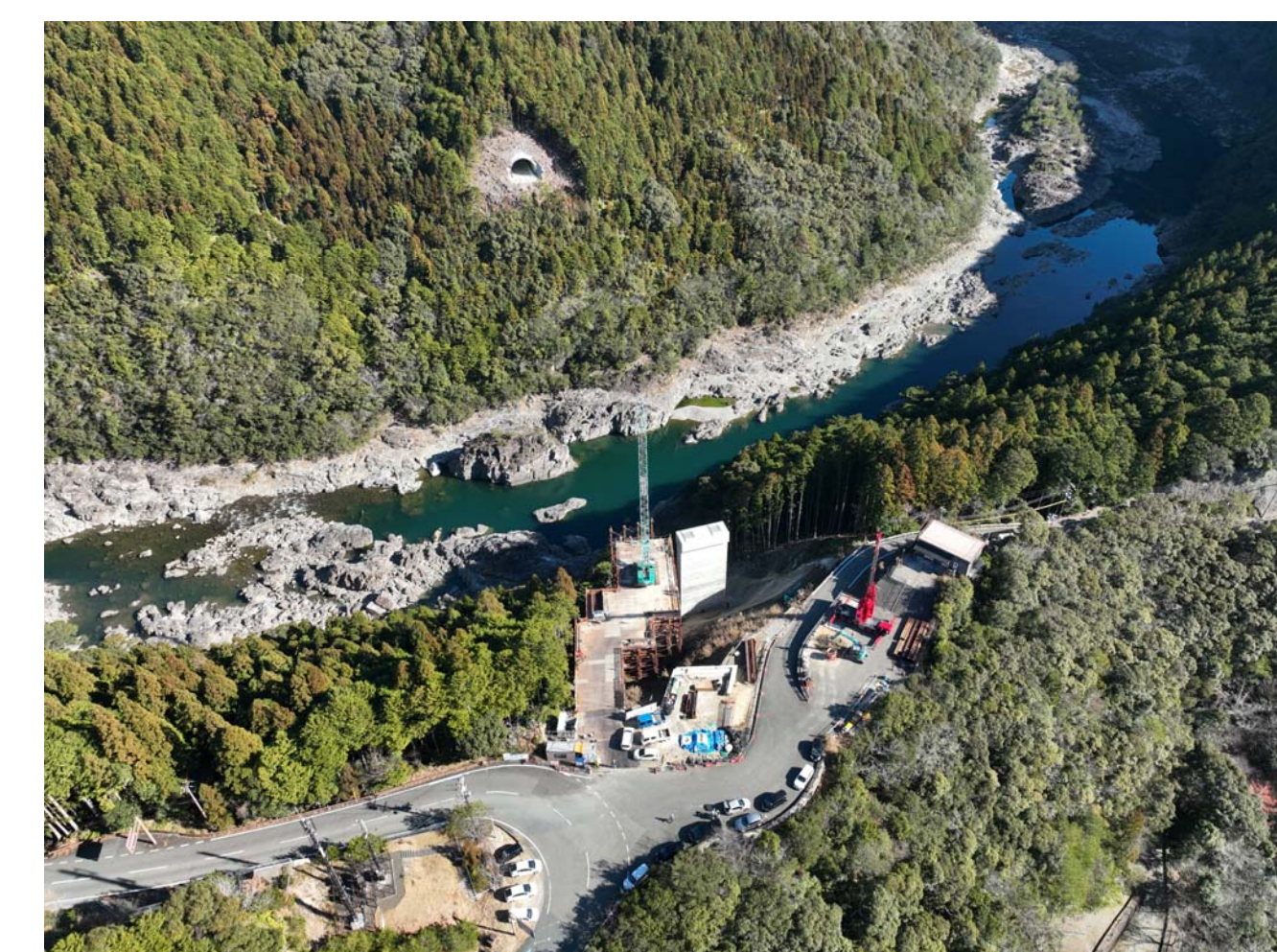
⑧ 北山村小松(3号橋AA2橋脚)
