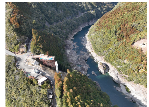
⑧ 北山村小松 (3号橋AA2橋脚)
