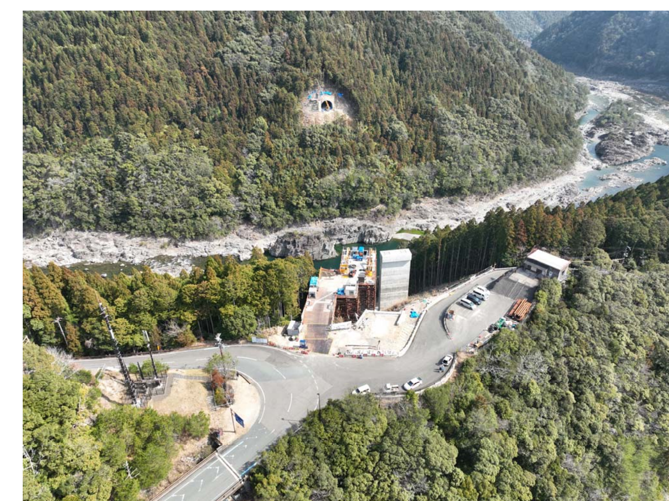
⑧ 北山村小松(3号橋AA2橋脚)
