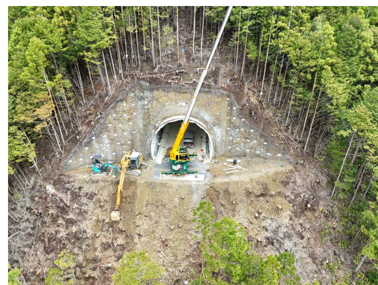
⑦ 熊野市紀和町小森(2号トンネル)
